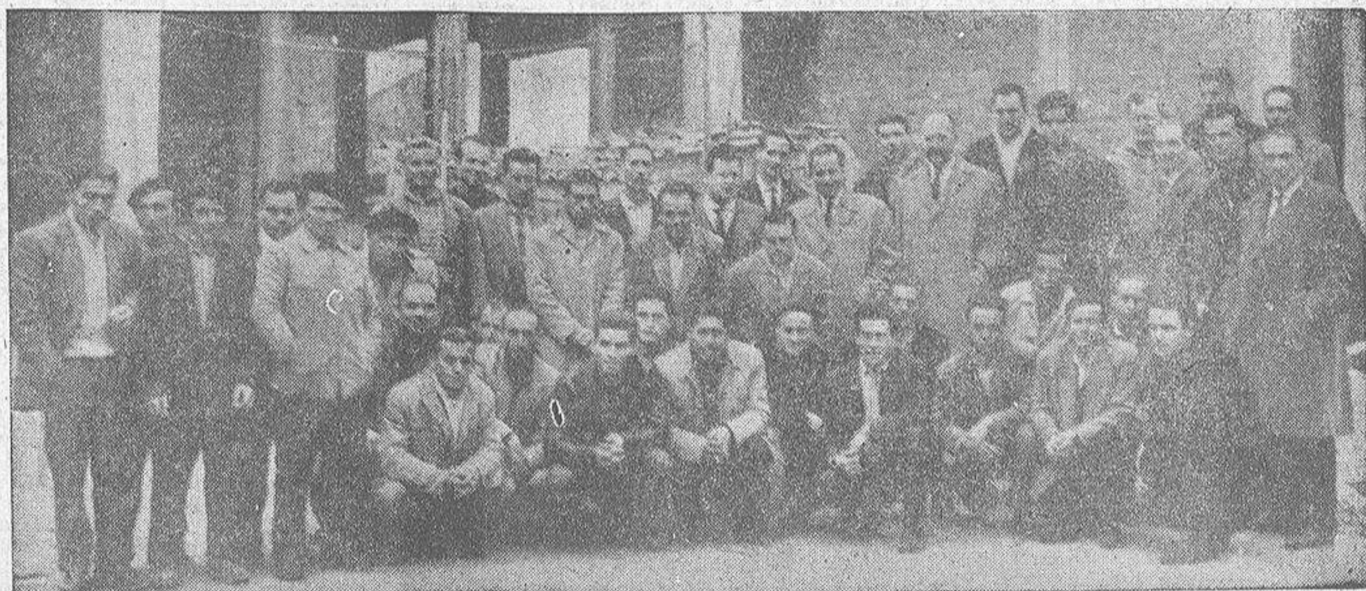
TECNICOS Y OBREROS QUE INTERVINIERON EN LA OONSTRUCCION DE LA ESTRUCTURA DE HORMIGON ARMADO
