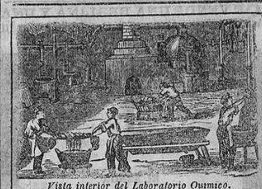
Vista interior del Laboratorio Químico.
