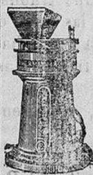
La torre llega con su mecanismo completamente montado, se la coloca en el lugar que ha de ocupar y una hora despues de su llegada el molino puede ya funcionar y moler.
