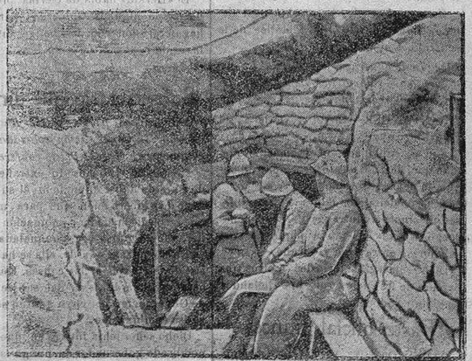
Entrada a una galería subterránea. Foto Información.
