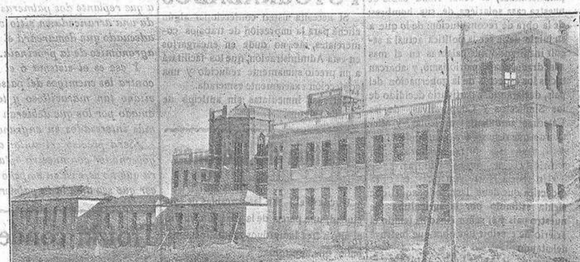
Fachada posterior. A la izquierda el pabellón de infecciosos y dementes, en el centro las salas de autopsias y cadáveres y en el ángulo derecho el pabellón magnífico destinado a niños. En segundo término, en el centro, preside estos lugares de dolor la esbelta edificación de la Capilla.
