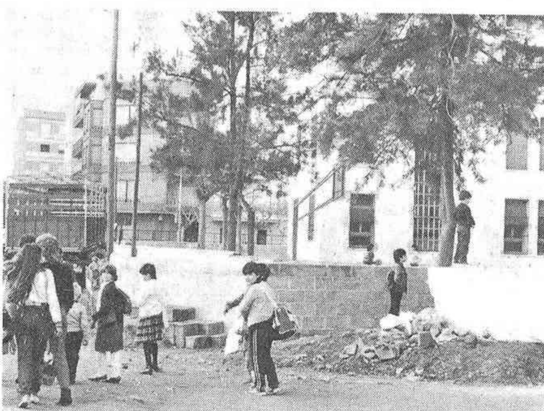
Colegio Público Pio XII, durante las obras de construcción de las vallas que delimitarán el recinto del centro
