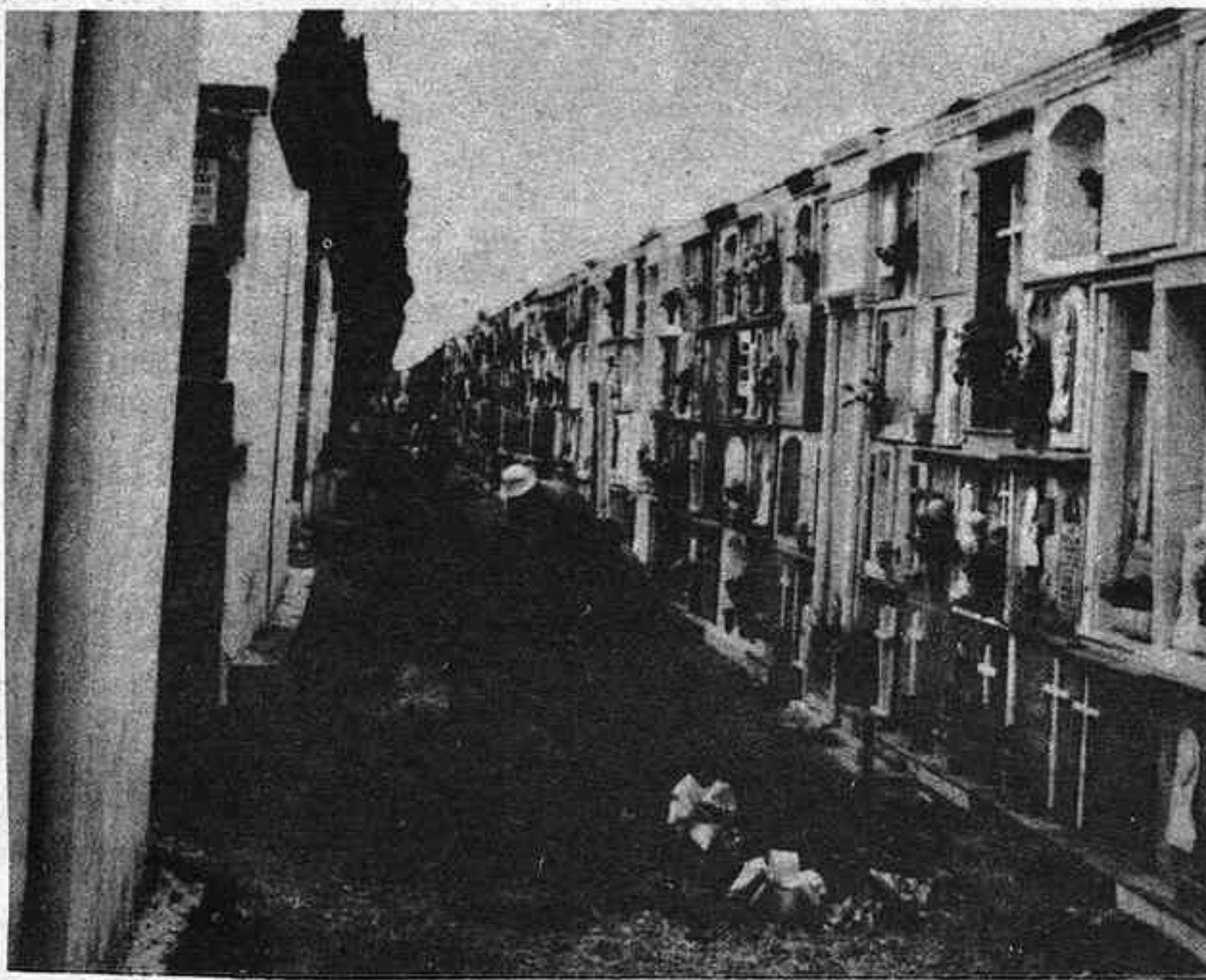
En estos días se procede a efectuar importantes obras de pavimentación, alcantarillado y jardinería en el cementerio.
