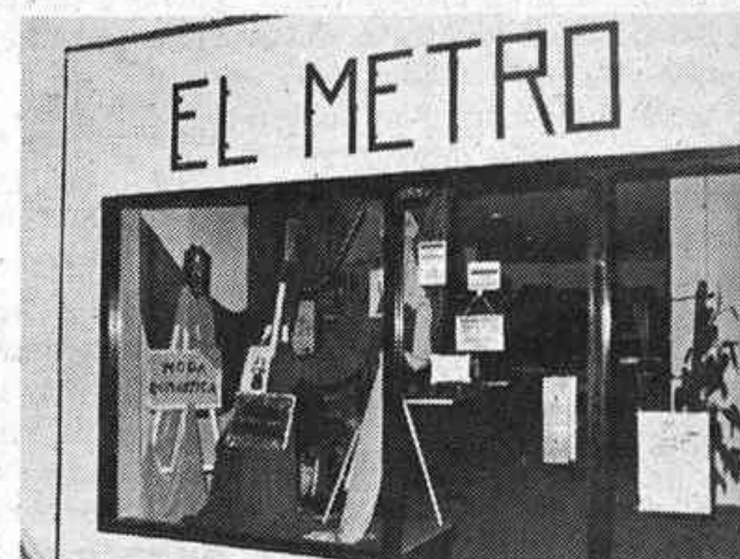
Alloza 125, tienda que coincide en su parte trasera con la joyería. (Foto Heredio)
