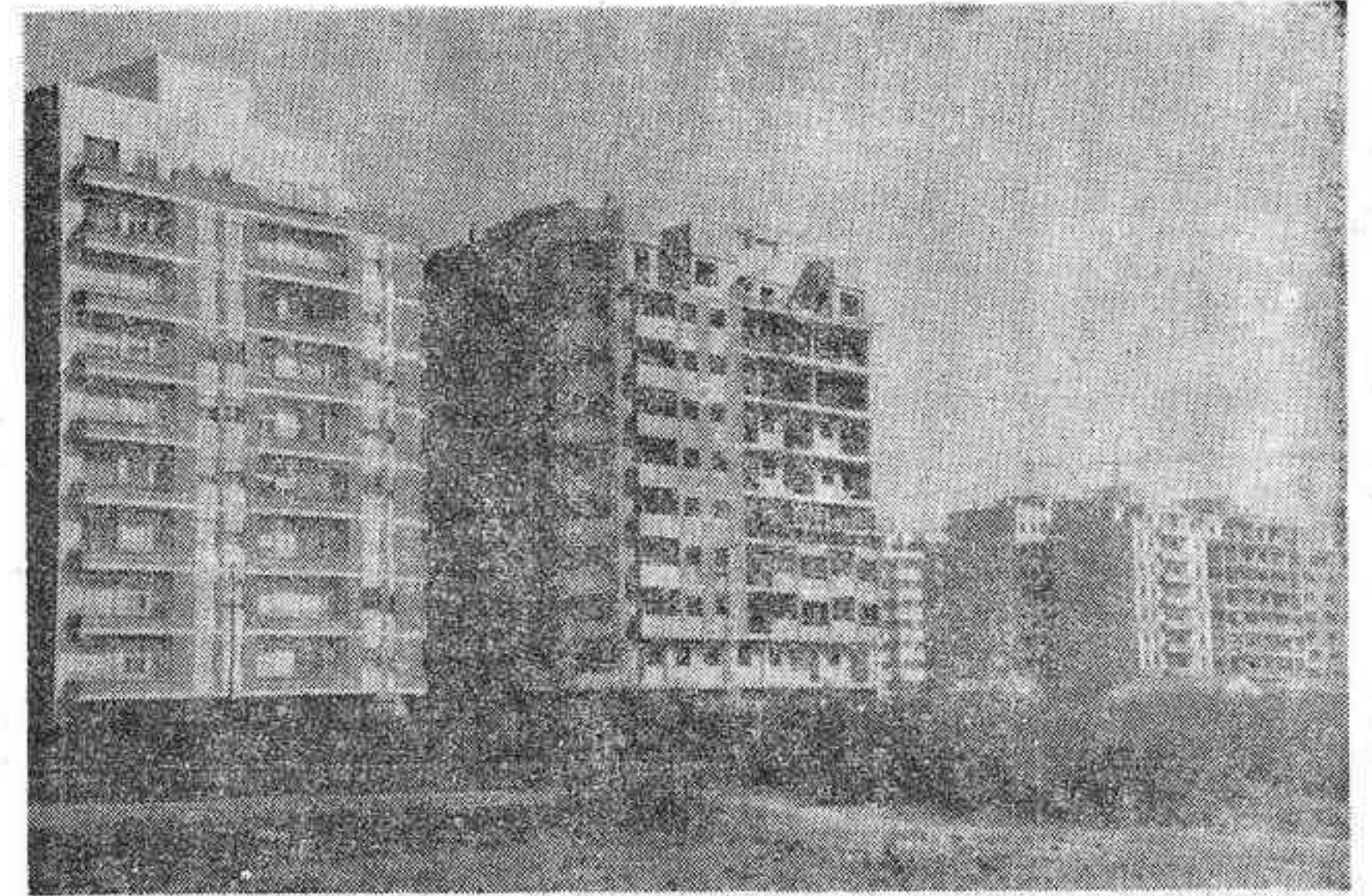
Las nuevas construcciones van ocupando solares que hasta hace algún tiempo eran suelo rústico
