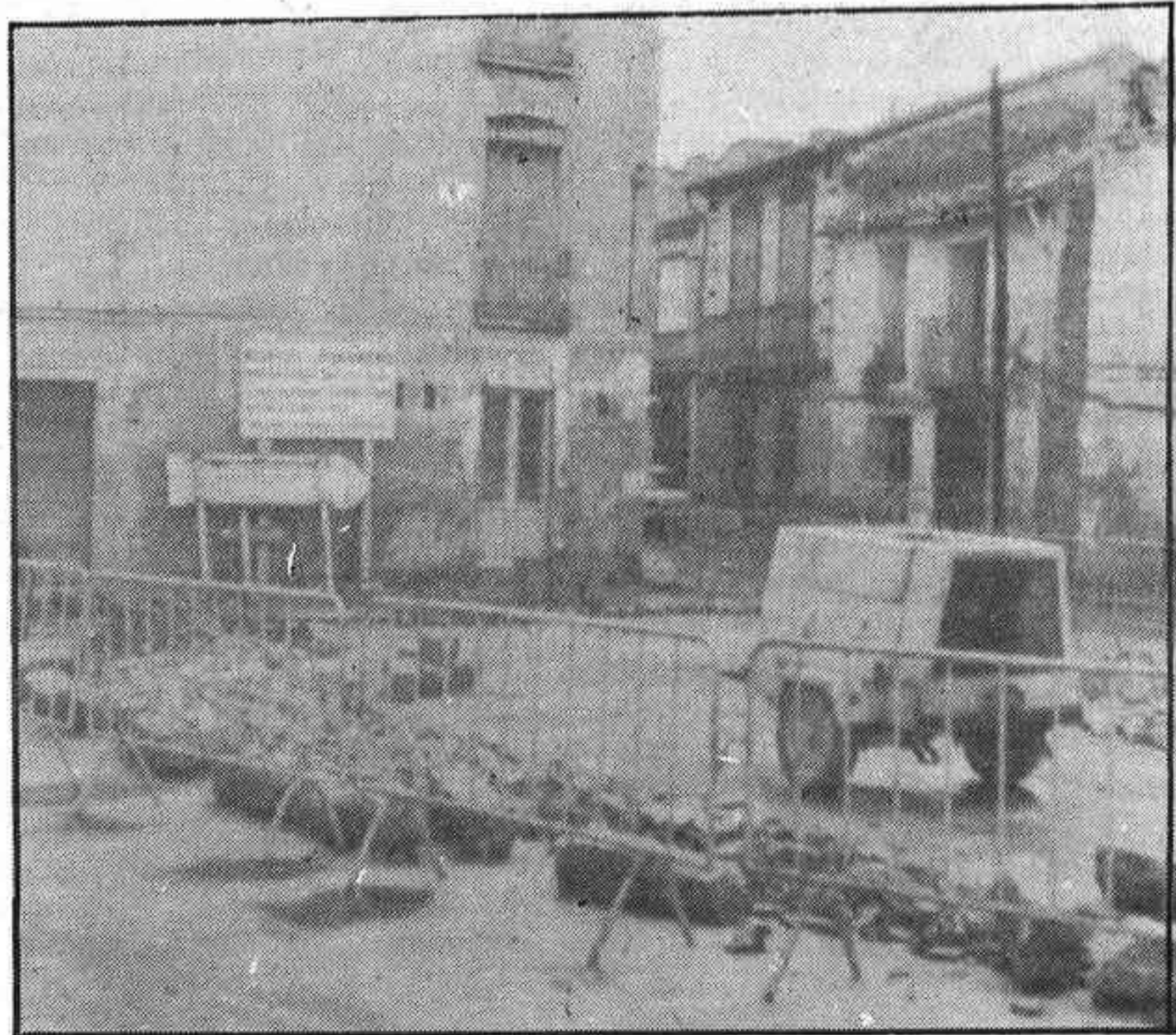
Las obras de la plaza permitirán la posterior remodelación del tráfico. XIMO
