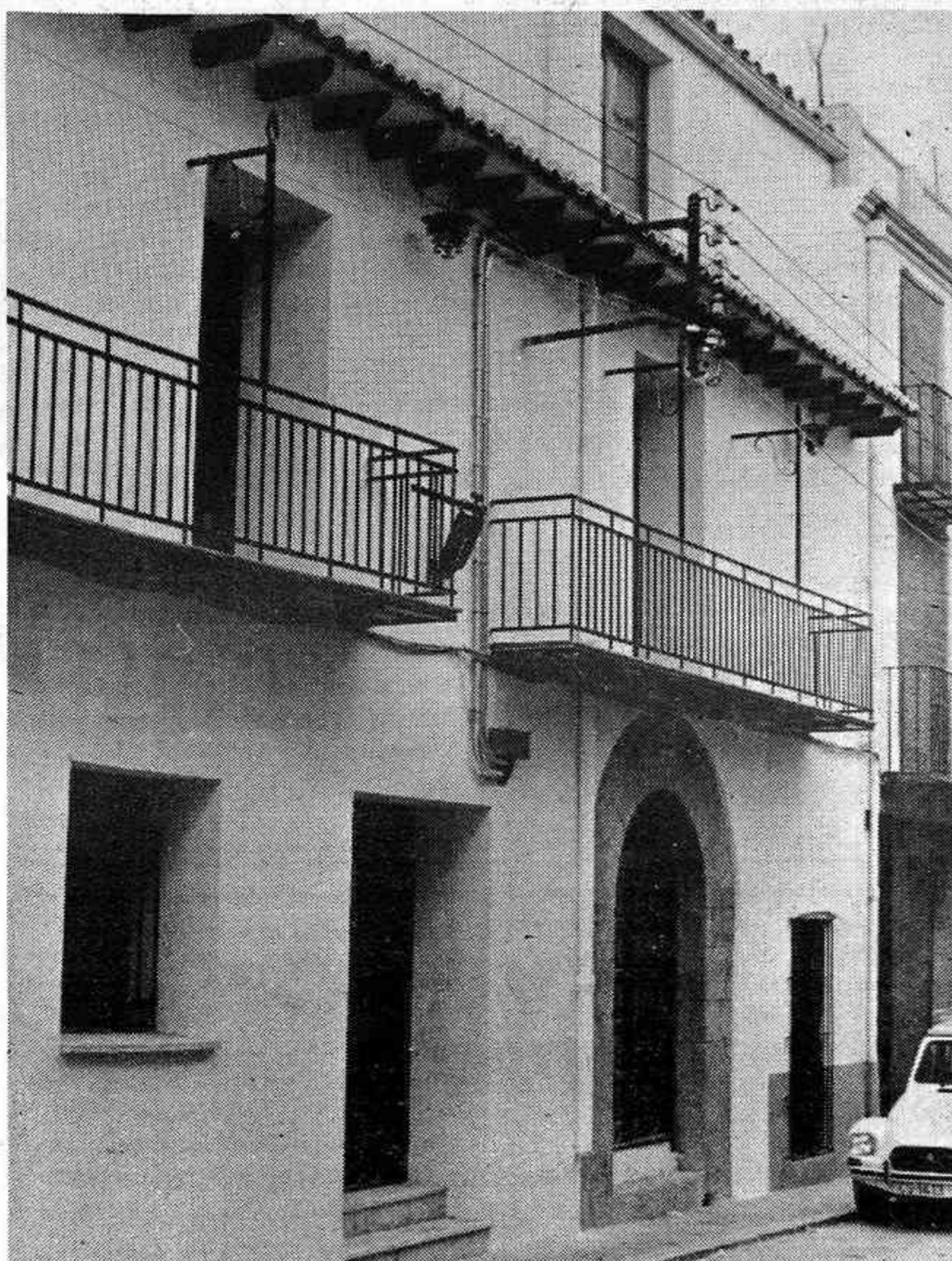
Vista parcial del Ayuntamiento, tras las obras
