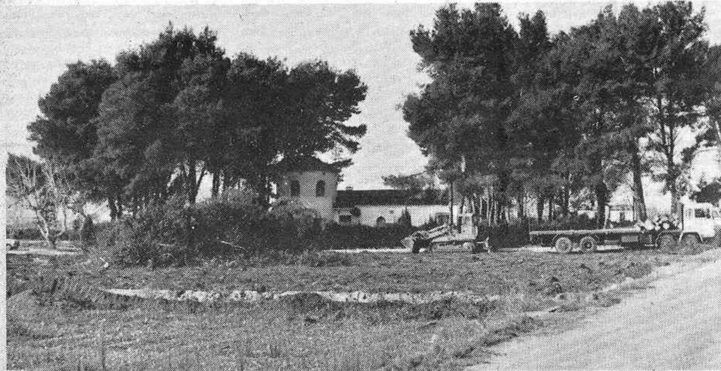
Se trabaja en la preparación del solar de la antigua «Masía Pinar»
