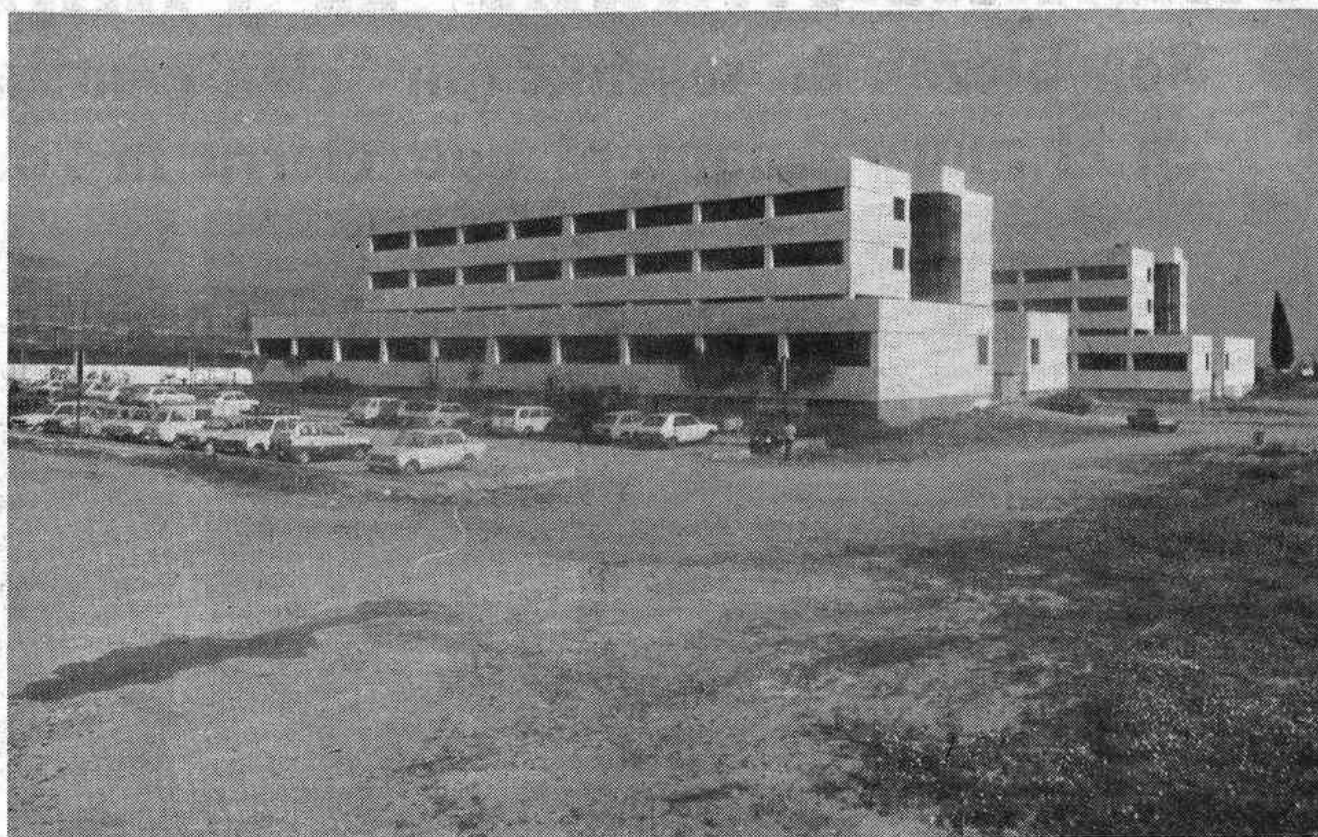
La Facultad de Derecho se construirá junto a la Polivalente.
