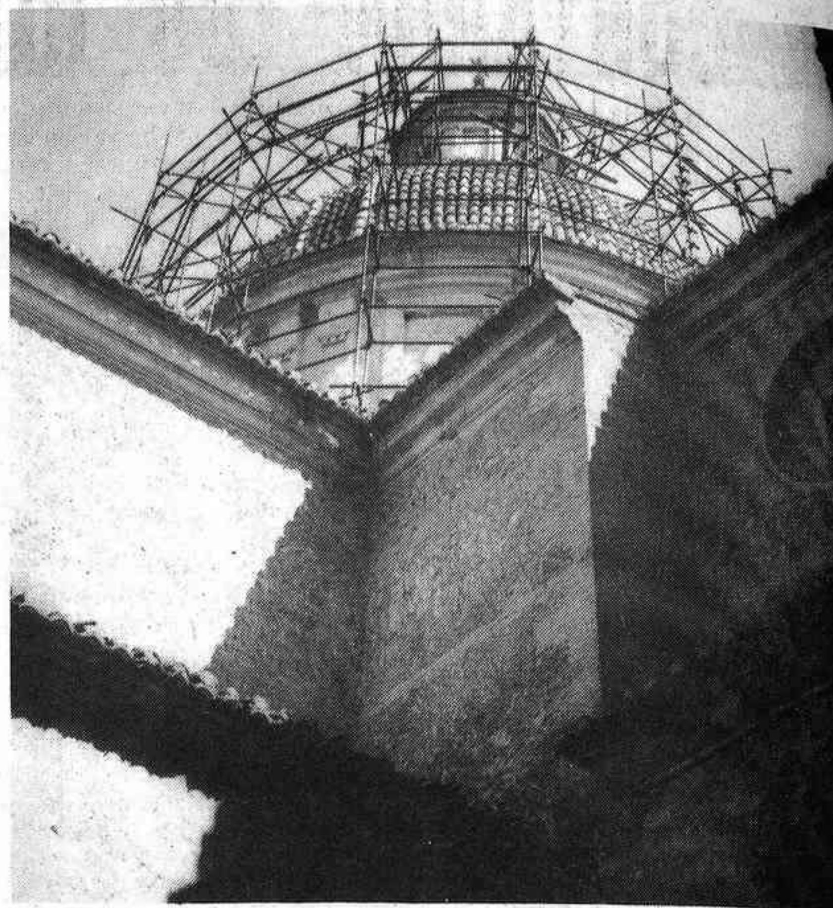
Cúpula del templo parroquial de Sot de Ferrer durante las obras.
