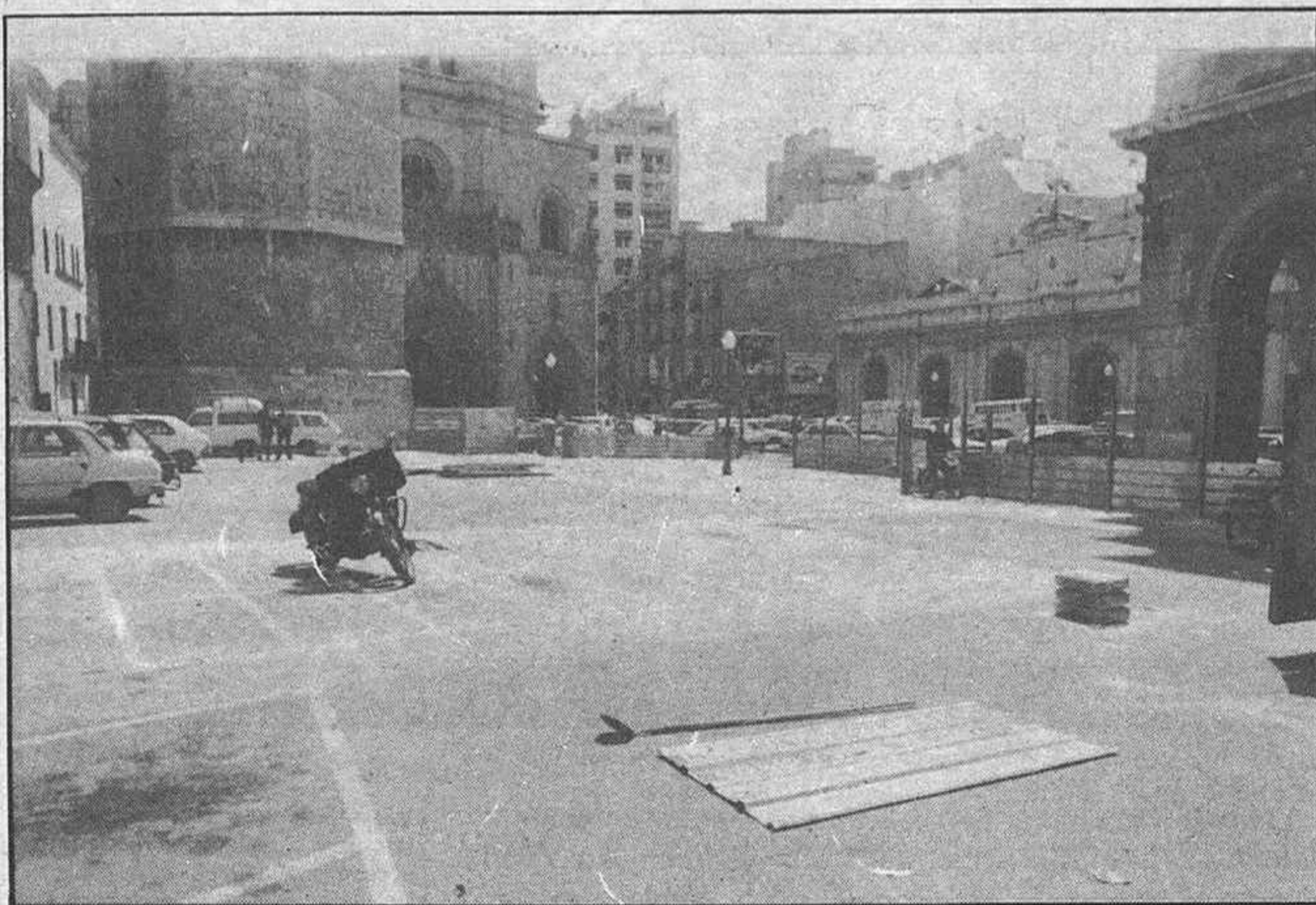
Han comenzado las obras de las nuevas dependencias municipales / VICENT GAMIR
