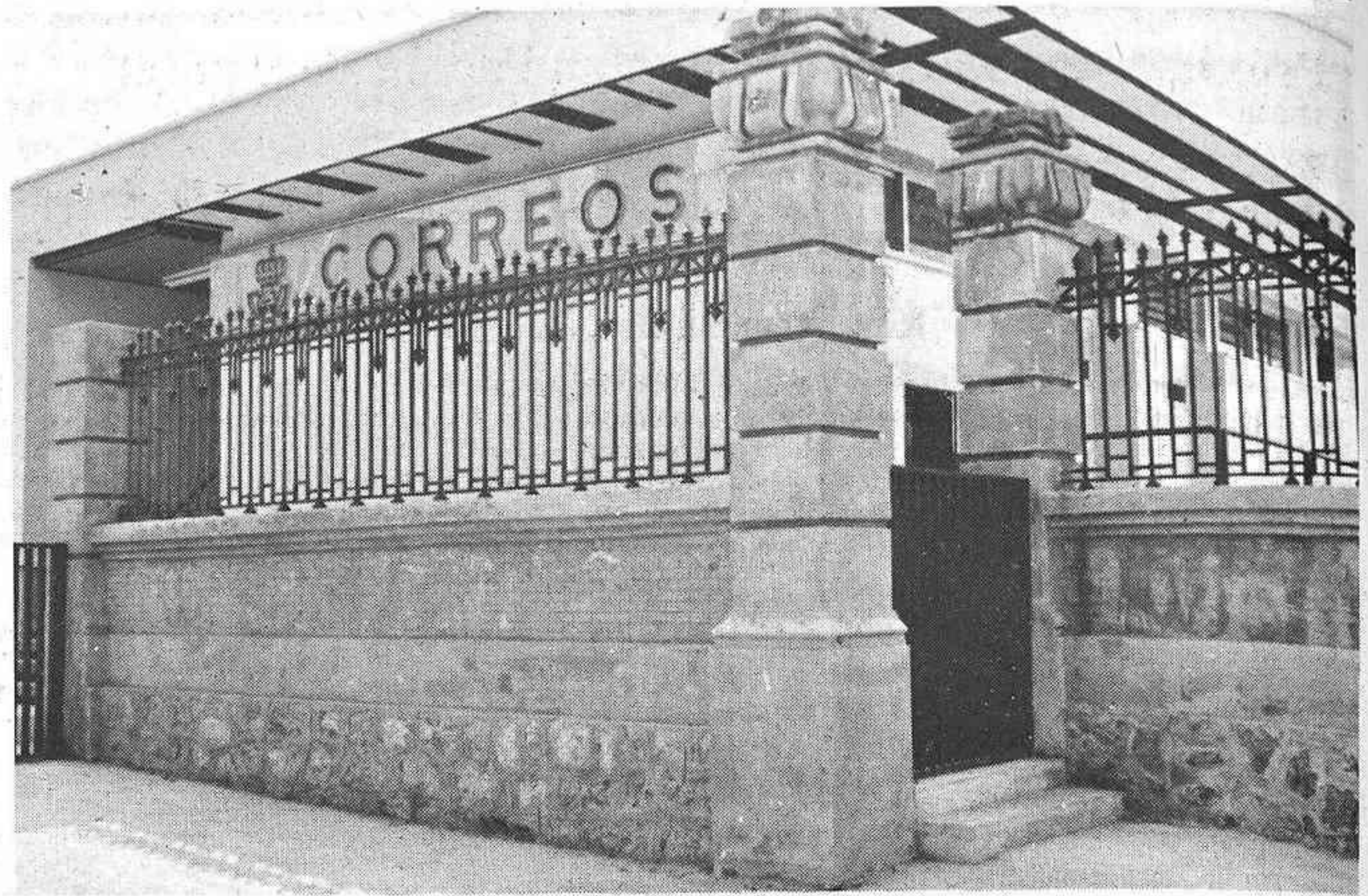
La estafeta de Correos de la Estación, la más afectada por la huelga
