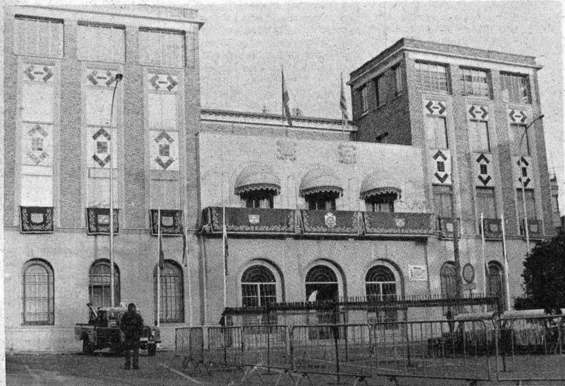
Las conclusiones extraídas indican que al fijar la cimentación sobre este suelo arcilloso, comenzó un proceso de asentamiento lento, lo que motivó un giro en la estructura del edificio y la aparición de enormes grietas. En este sentido, el ala derecha del edificio, que se encuentra en peor estado, ha cedido 16 milímetros por cada diez metros de altura. De esta manera, al tratarse de suelos arcillosos, el proceso es bastante lento y se prevé que puede durar varios años.
