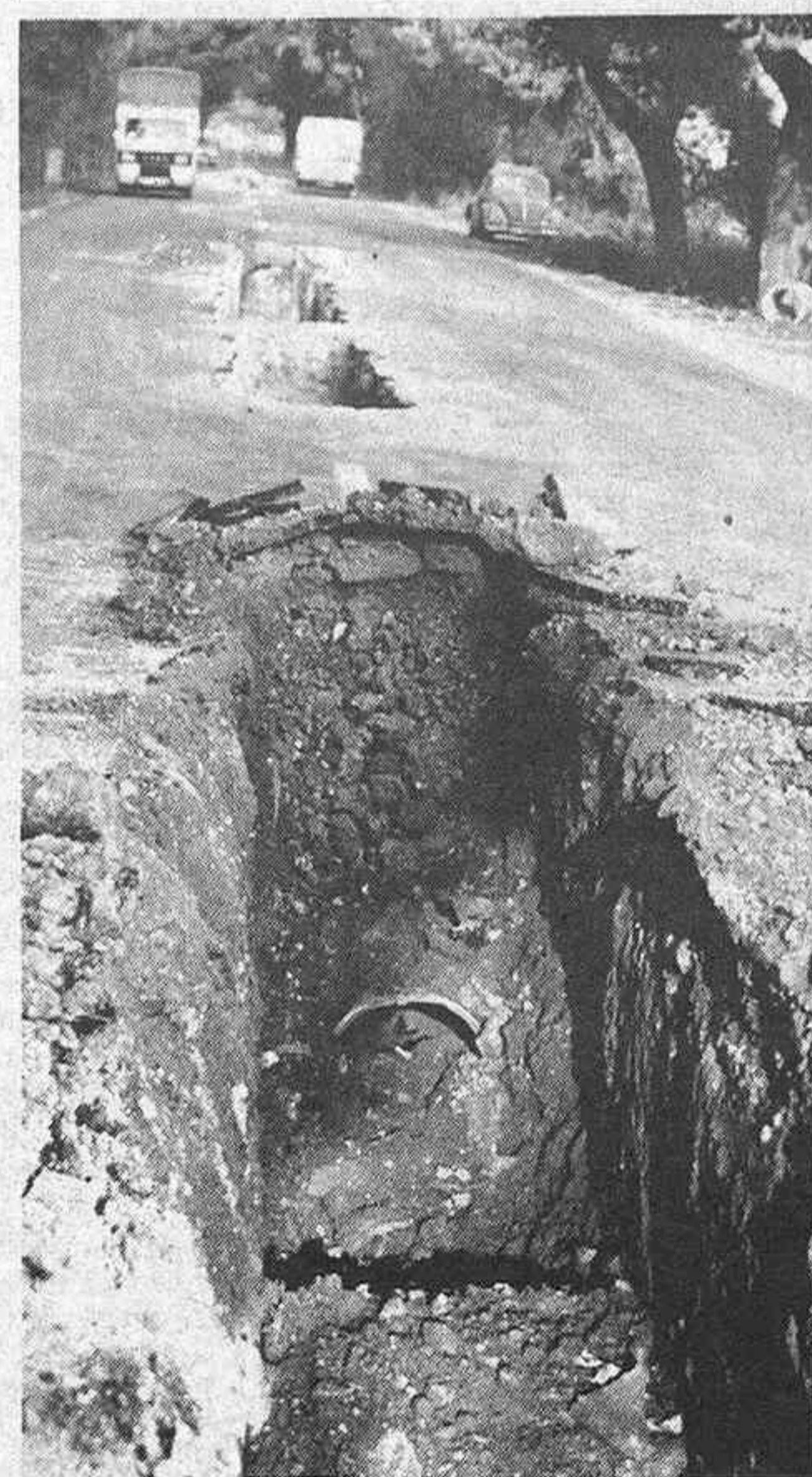
Reparación del colector de la Avenida Valencia
