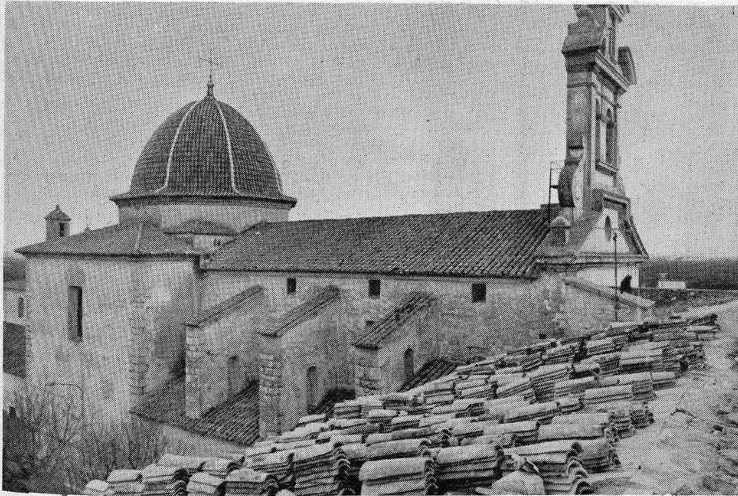
Trabajos de saneamiento de la techumbre para evitar posteriores filtraciones.
