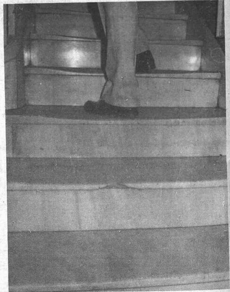
Miles de pisadas confirman el desgaste del mármol de los escalones del edificio. Edificio que precisa de una reforma, caso de que no se decida —como sería lógico— por la construcción de un nuevo ambulatorio.
