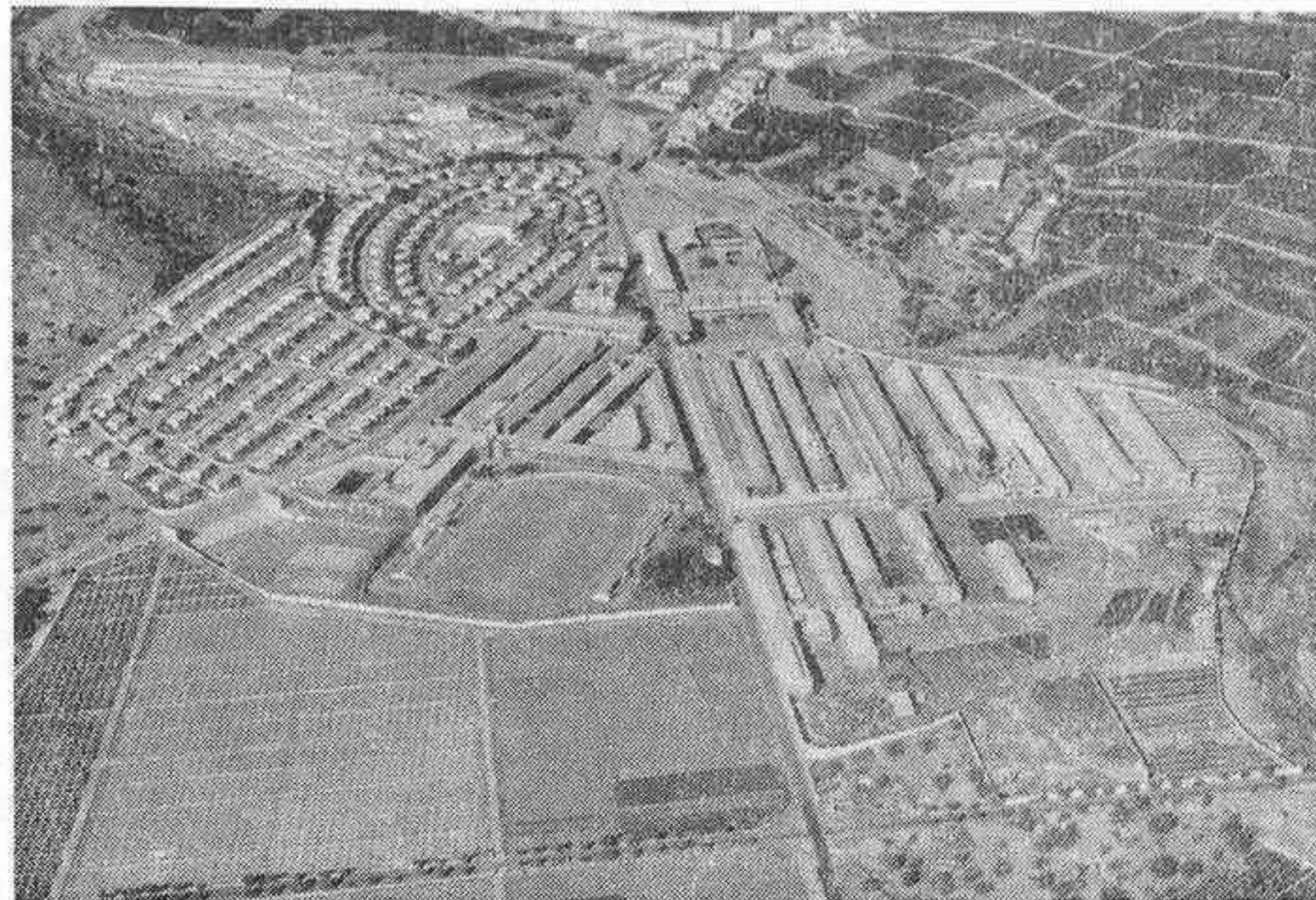
Vista aérea de la factoría "Segarra", en Vall de Uxó; y de la colonia del mismo nombre, a la izquierda de la foto
