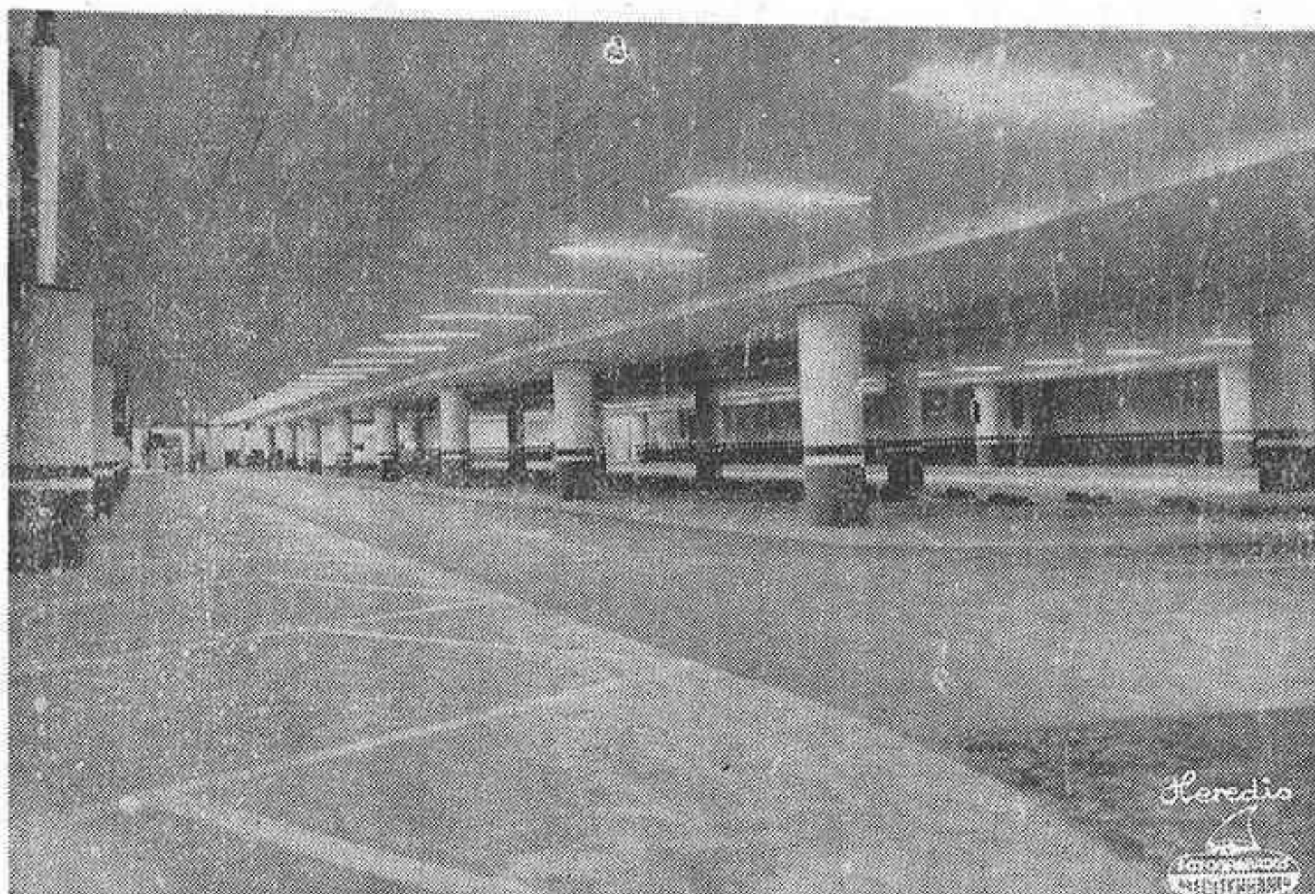
Aspecto de una de las plantas del nuevo aparcamiento subterráneo.
