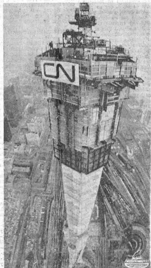
TORONTO (Canada). — Vista aérea de la Torre CN, luciendo en su parte superior los moldes de hormigón para su último piso. Dicho edificio tendrá una altura de 446'520 metros y su costo es de 21 millones de dólares. Después de que un mástil para comunicaciones sea añadido, la torre será el edificio más alto del mundo. Será inaugurado en 1975. — (Telefoto Cifra Gráfica)
