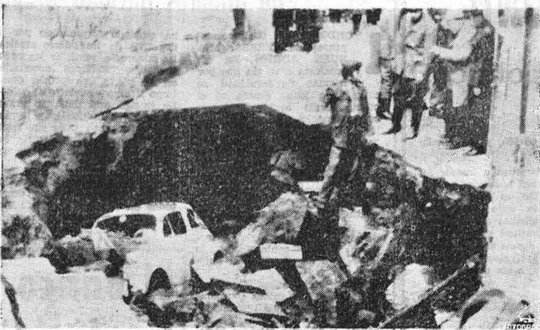
NAPOLES. — Un gran socavón se ha producido en una calle de esta localidad italiana. En la fotografía un aspecto del mismo, en cuyas entrañas se encuentra un pequeño turismo. Según los informes no ha habido que lamentar desgracias personales. — (Telefoto CIFRA GRAFICA)
