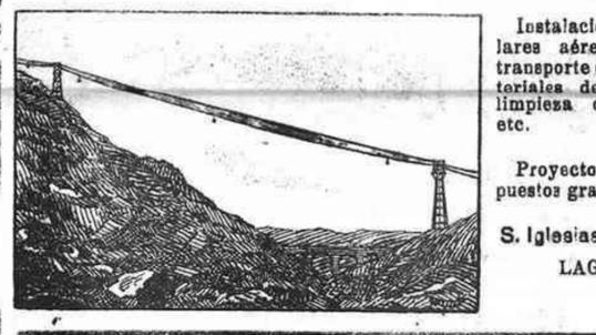
Instalación de funiculares aéreos para el transporte de frutos, materiales de embarque, limpieza de embalajes etc.
