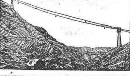
Instalación de funiculares aéreos para el transporte de frutos, materiales de embarque, limpieza de embalses etc.
