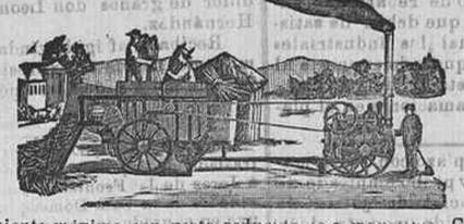
Rendimiento máximo con gasto reducido. Construcción muy sólida, de poco peso y fácil transporte, aun sobre terrenos muy quebrados. Locomóviles puestas en presión en pocos minutos, mediante un nuevo aparato patentizado.
