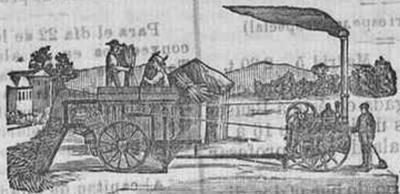
Rendimiento máximo con gasto reducido de combustible. Construcción muy sólida, de poco peso y fácil transporte, aun sobre terrenos muy quebrados. Locomóviles puestas en presión en pocos minutos, mediante un nuevo aparato patentizado.
