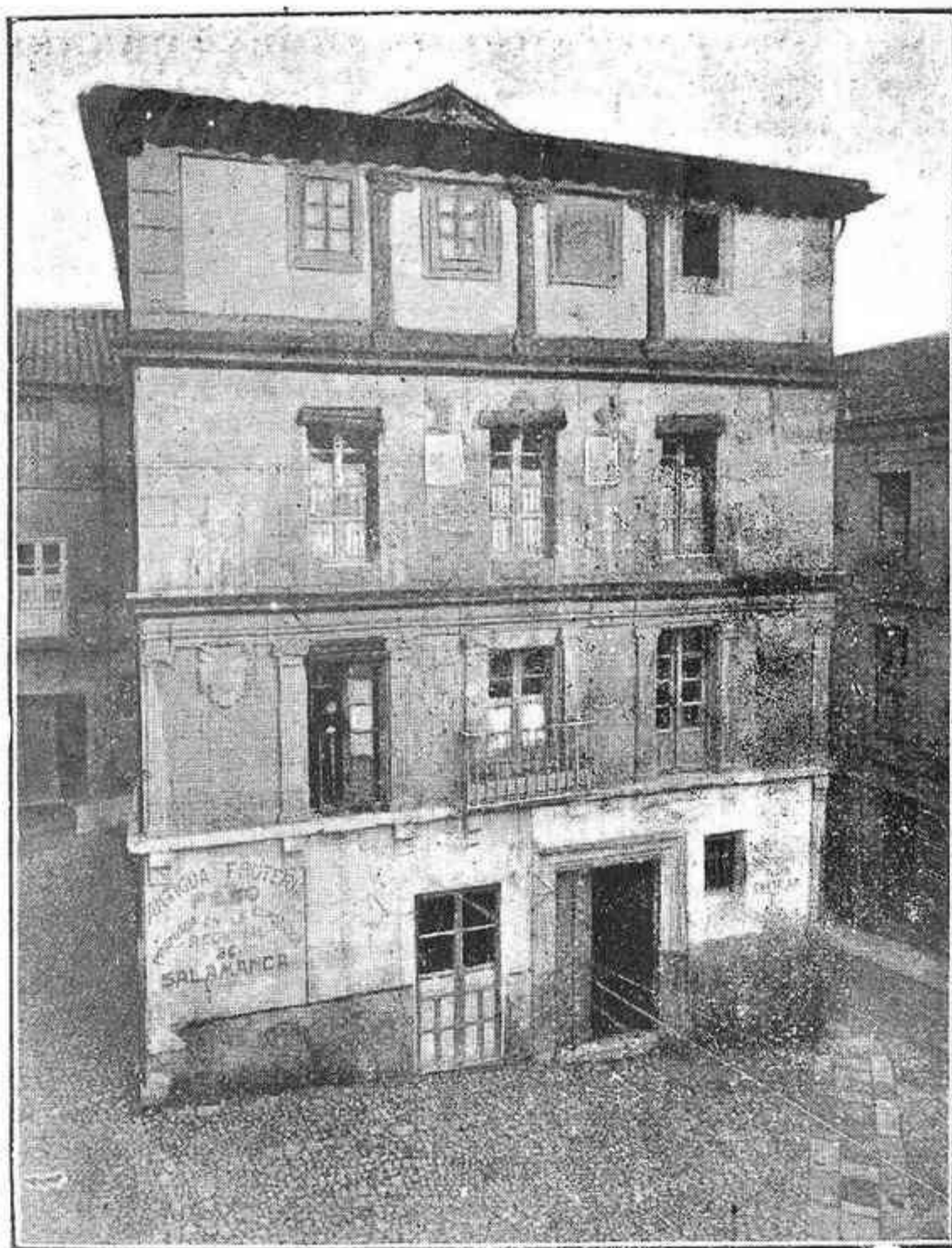
CASA EN LA PLAZUELA DEL PESO
