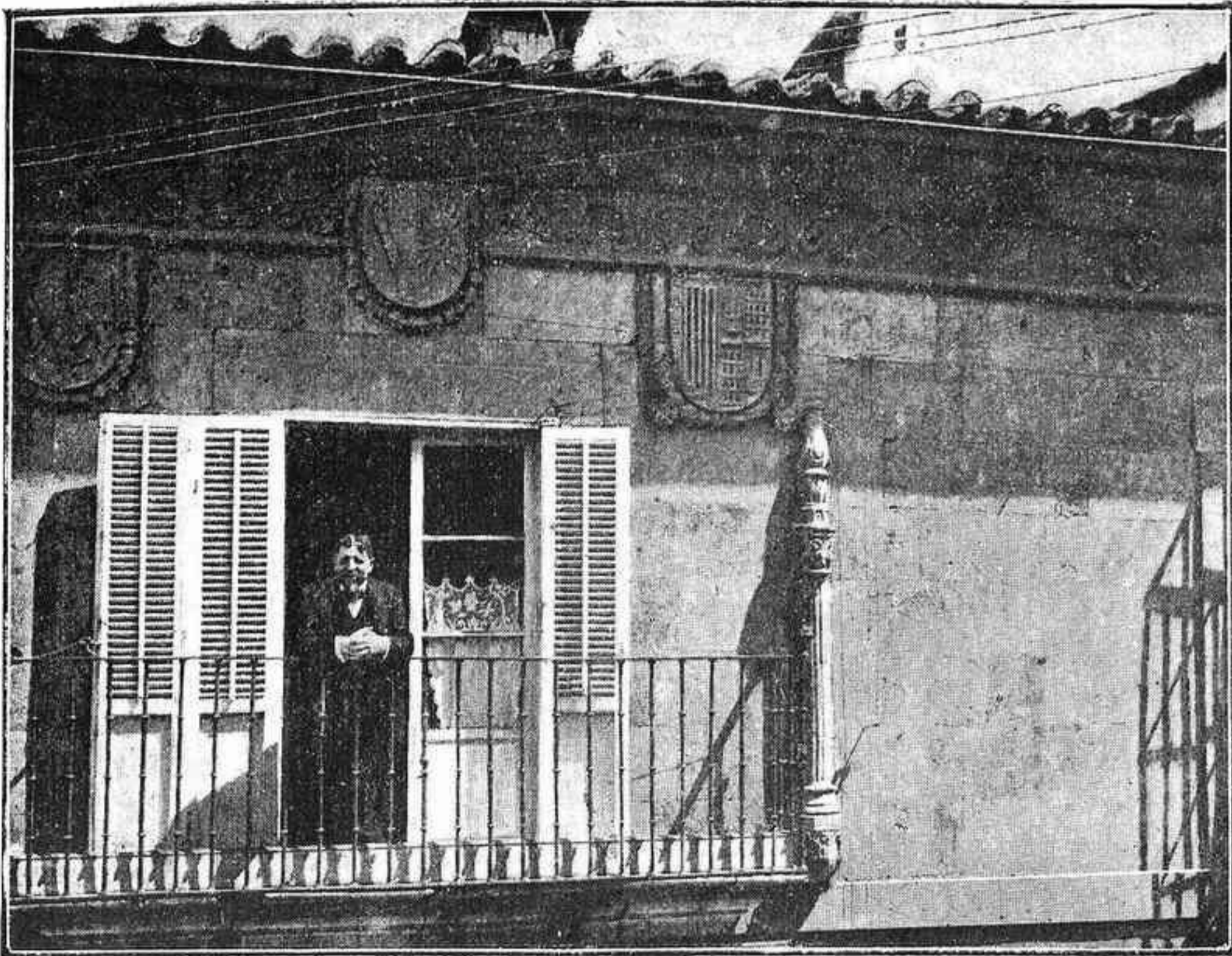
CASA DE LOS RODRÍGUEZ DE LA BANDA EN LA CALLE DE TORO
