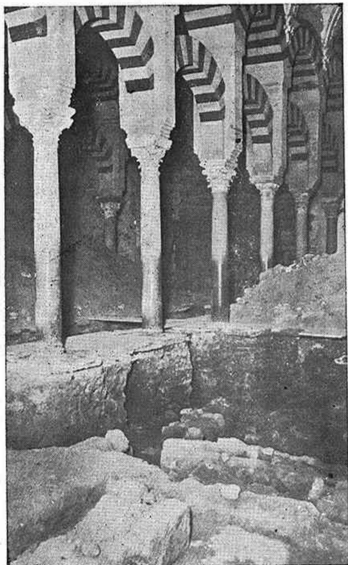
Excavaciones que en la actualidad se están realizando en el subsuelo de la Mezquita-Catedral, y que han dado por resultado el hallazgo de un templo visigodo
