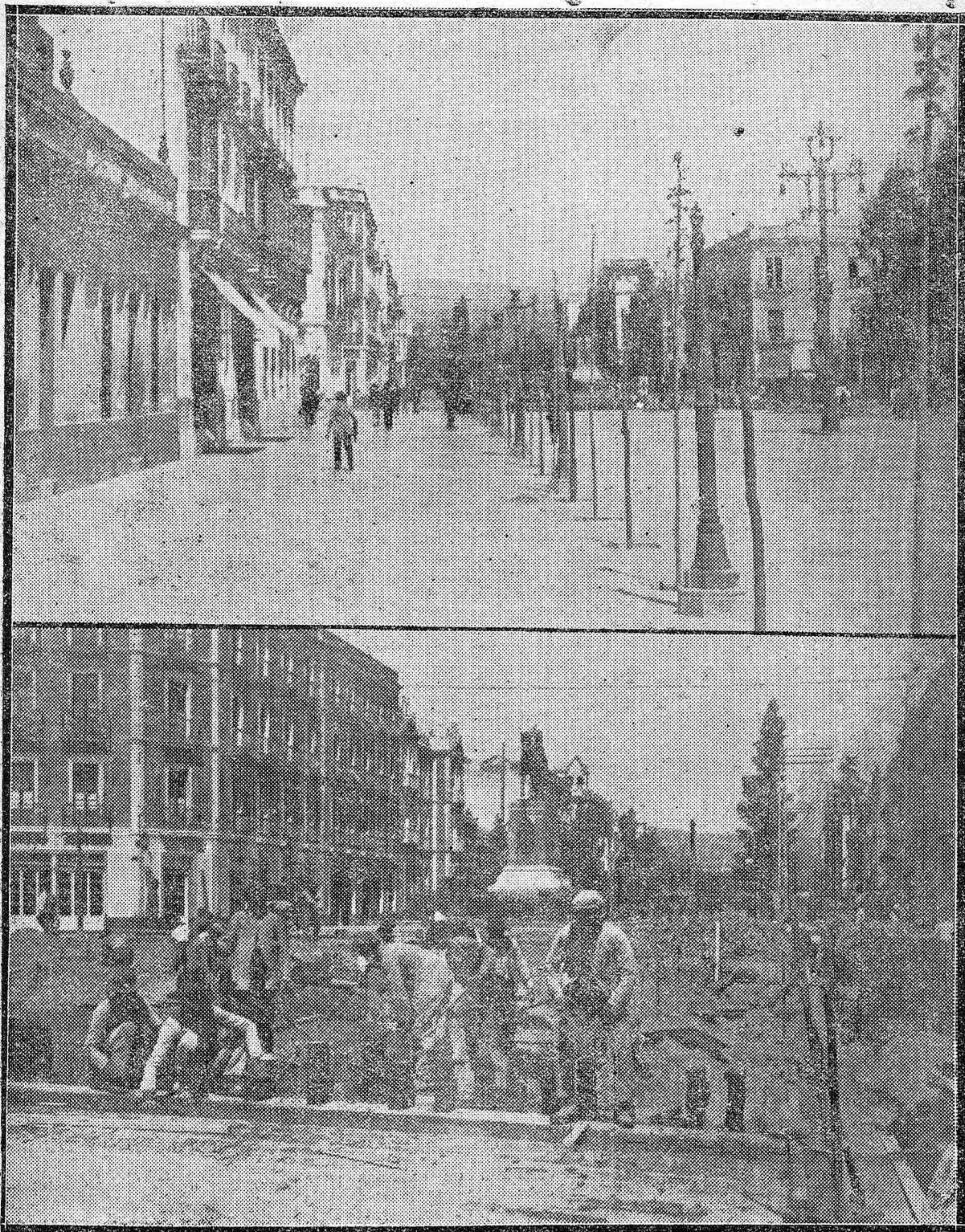
LAS REFORMAS DE CORDOBA. --Aspecto de la admirable pavimentación del Gran Capllán, al ser convertido en "boulevard".--Curioso y rápido procedimiento empleado para la colocación de los ladrillos de asfalto comprimido.
