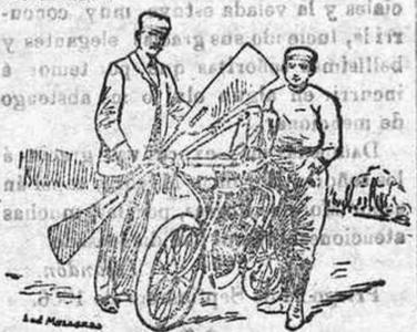
El aparato que fué probado es un motociclo provisto de un motor Buchet con dos cilindros en V de corazón y fuerza de 6 H. P. el cual acciona por medio de dos poleas, un arbol á cuya extremidad hay fija una hélice, cuyas paletas son de aluminio de un diámetro de un metro cincuenta. Esta hélice está colocada en la parte delantera de la bicicleta.
