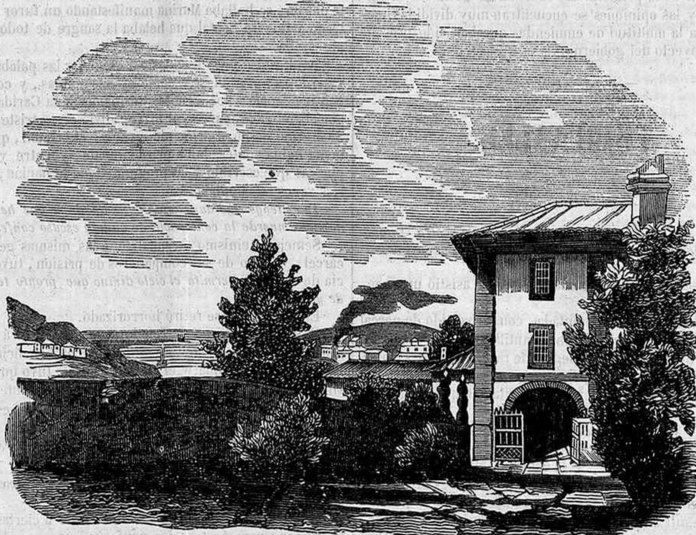
Casa en que ha muerto Carlos Alberto en Oporto.
