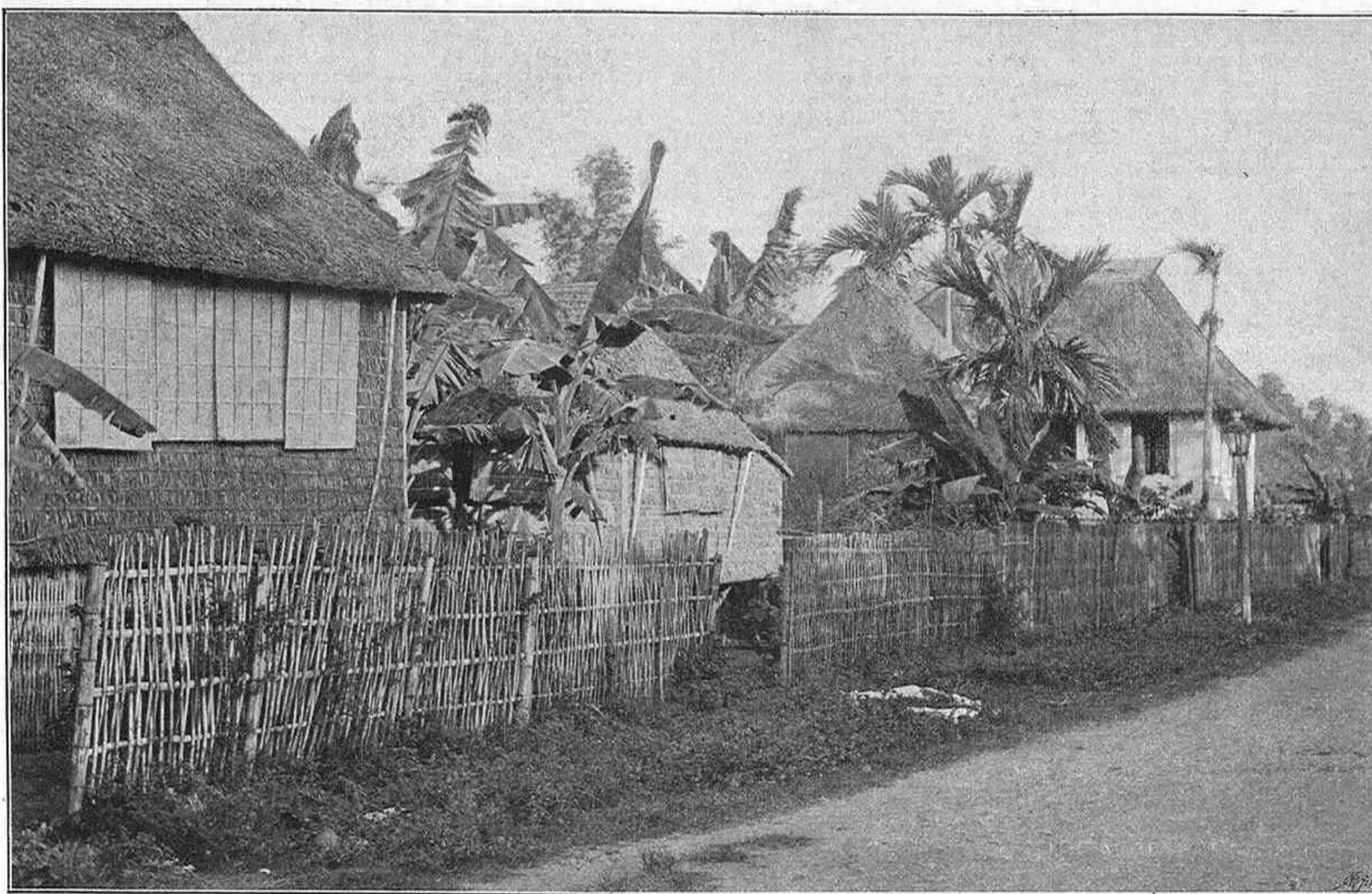
ISLAS FILIPINAS. — Manila. — Barrio de la Ermita. — Agrupación de casitas de caña y nipa denominadas de materiales ligeros
