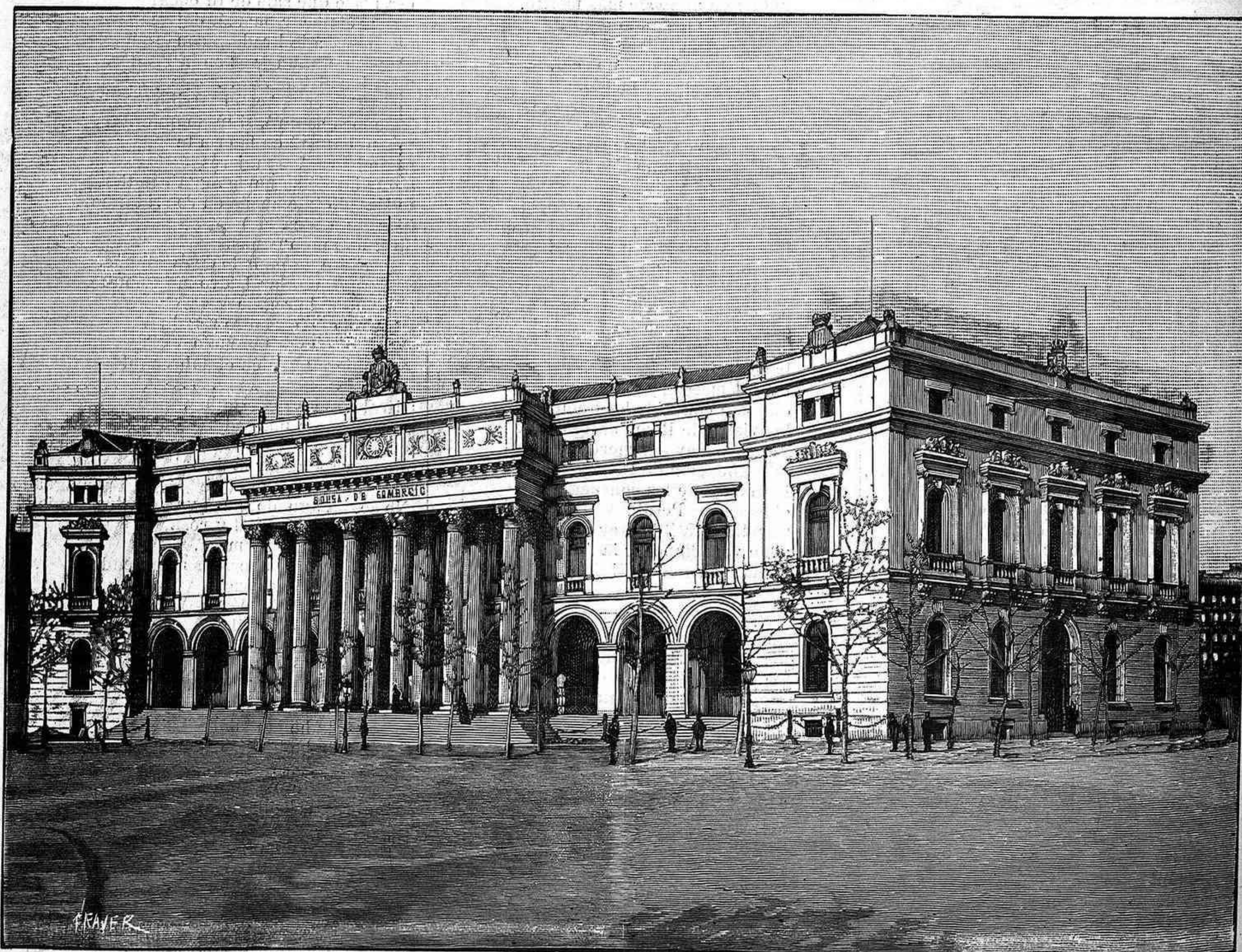
MADRID.- FACHADA DEL EDIFICIO DE LA BOLSA
