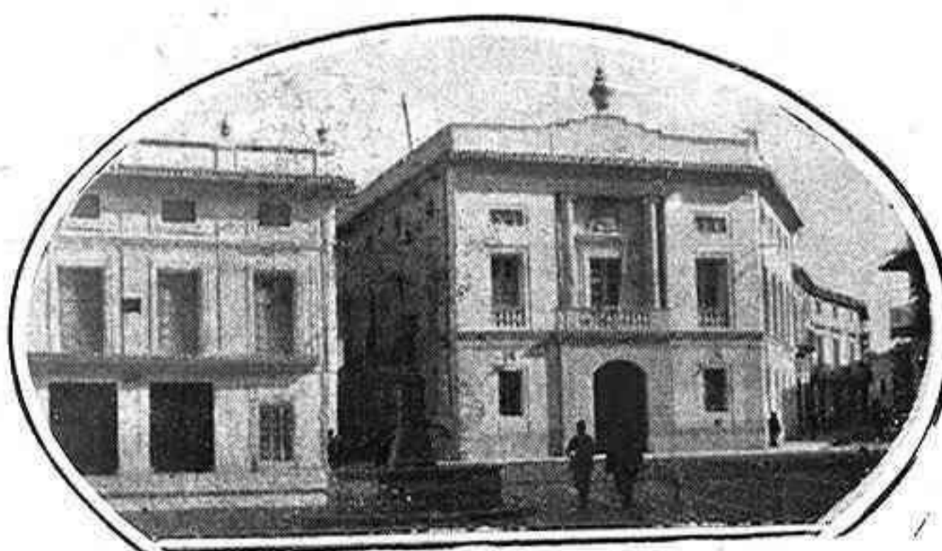
Fachada principal de las Casas Consistoriales en la plaza de la Constitución
