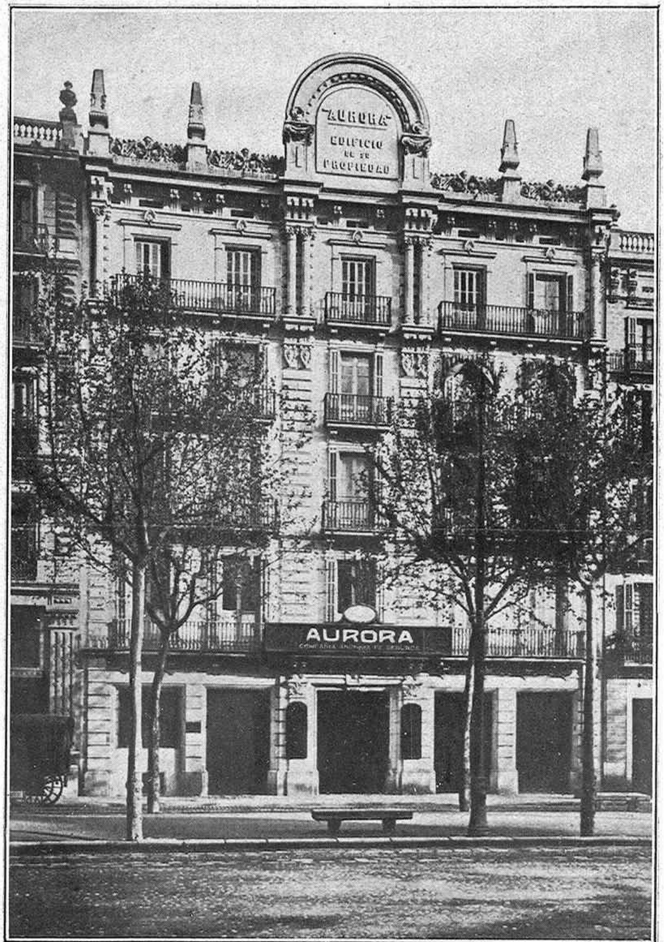
Edificio propiedad de la Compañía de Seguros «Aurora», donde ésta tiene establecida su Sucursal en Barcelona
