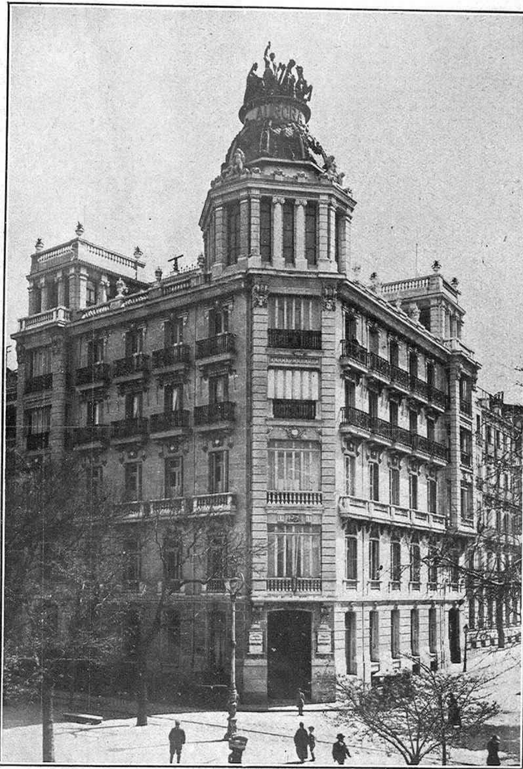
Espléndido edificio que la Compañía Anónima de Seguros «Aurora», posee en el Paseo de Recoletos, de Madrid
