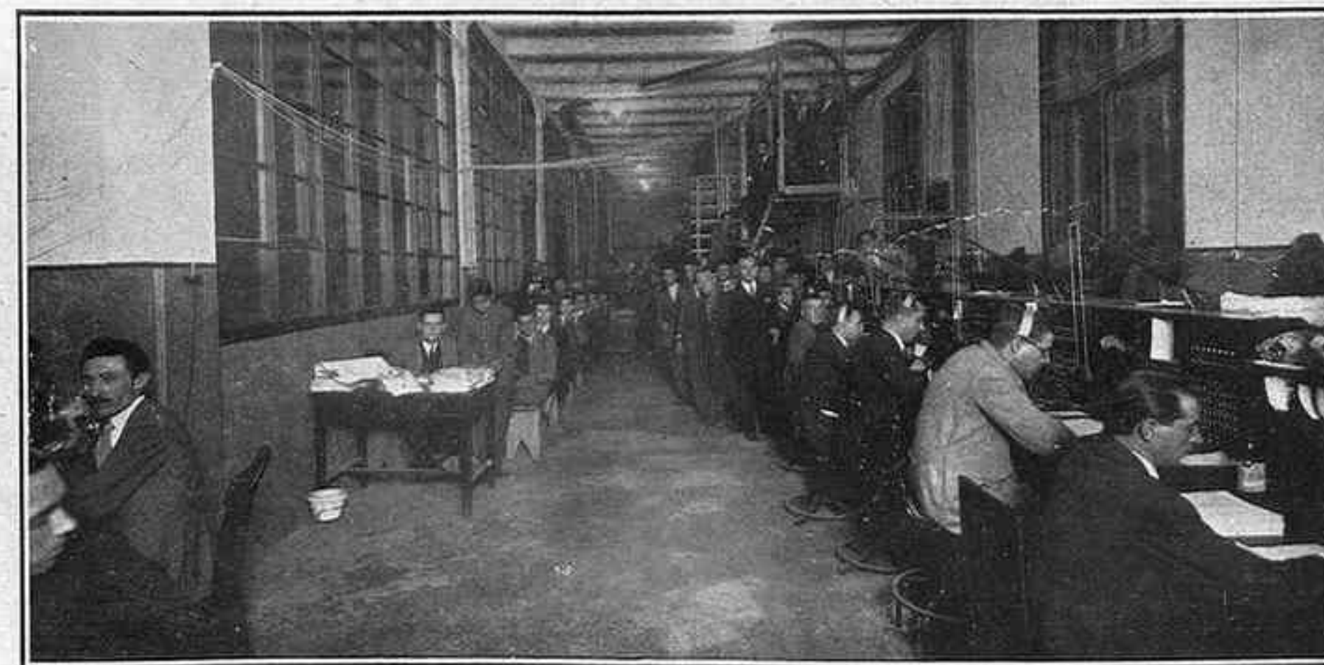
Mesas de prueba de la Central de Gran Vía
