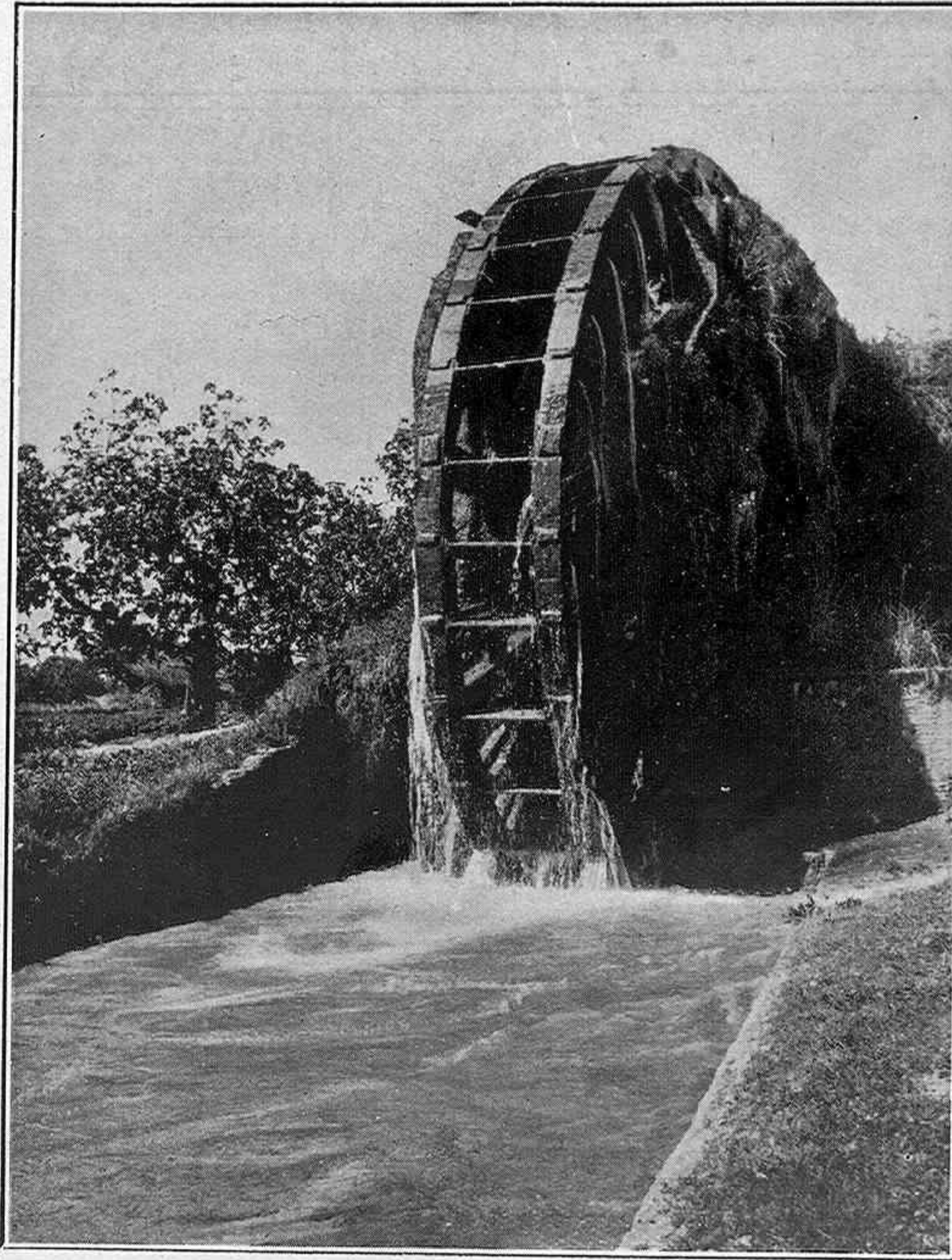
La «Nora» elevadora de agua para el riego, por cuyos arcaduces mana el tesoro que enriquece la vega murciana
