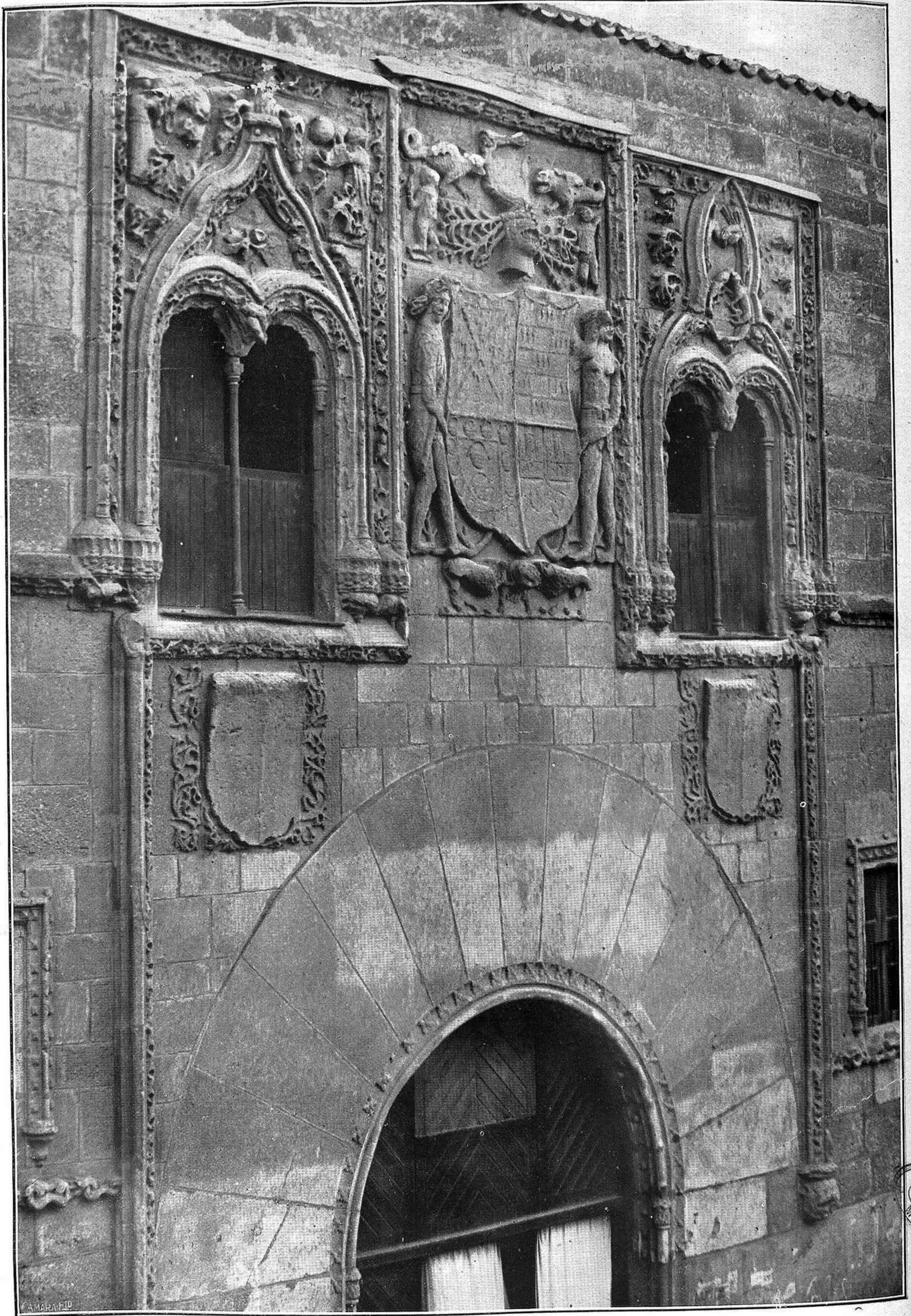
Bellísimos ventanales del palacio del Morro en Zamora
