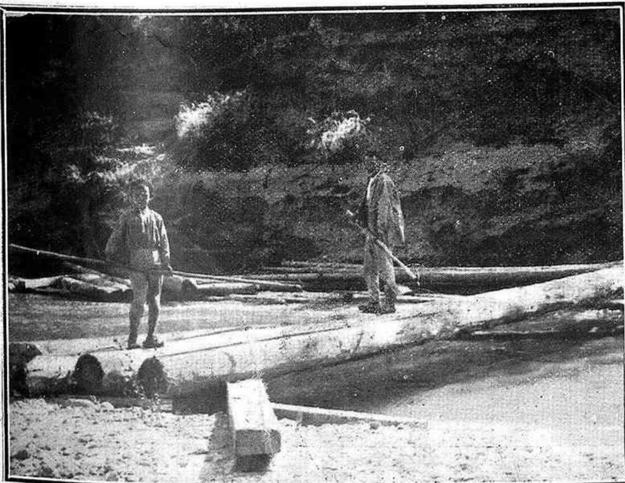
Armando un puente provisional para el servicio de la madera
