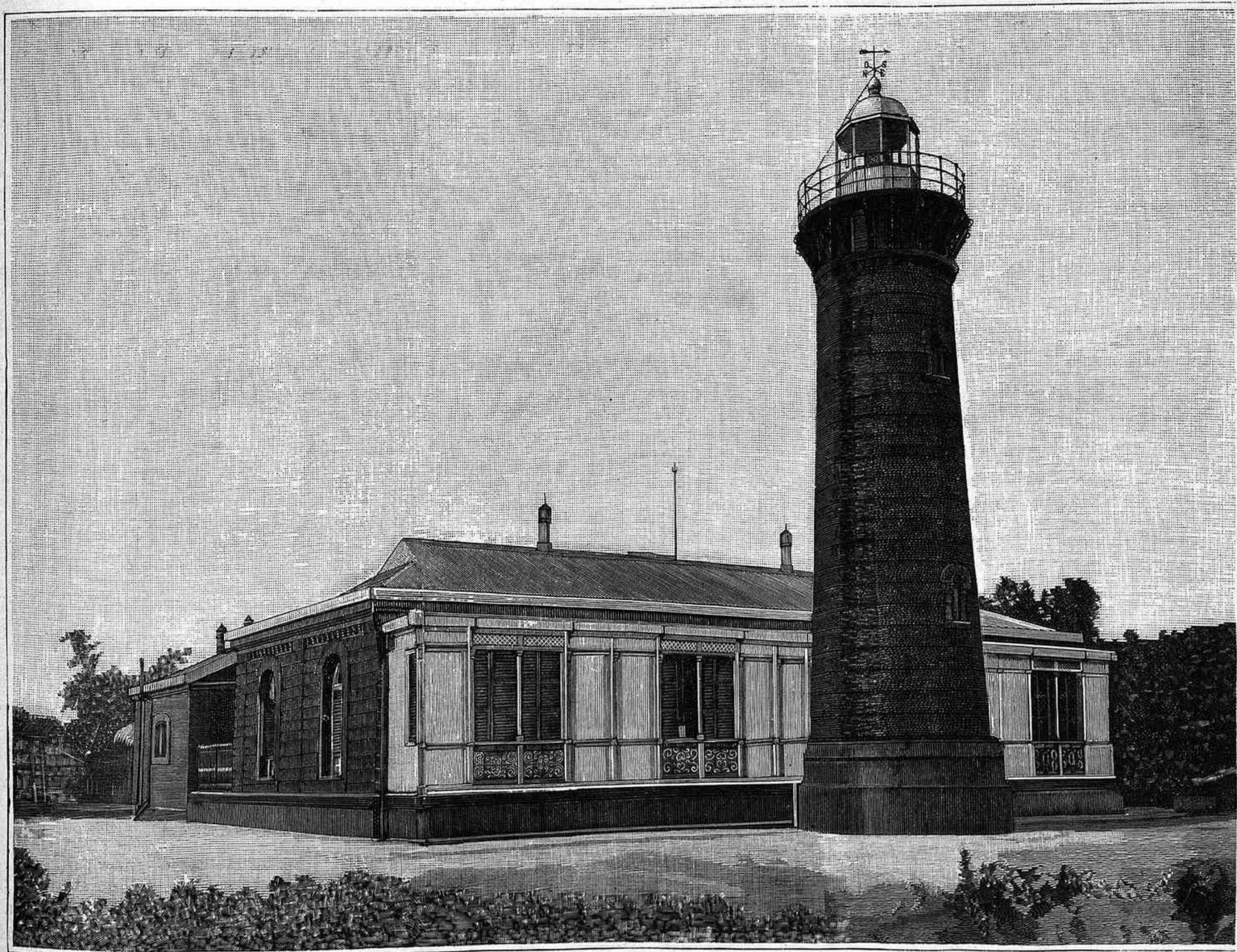
FILIPINAS.—Nuevo faro de la punta de Santiago, en Manila.
