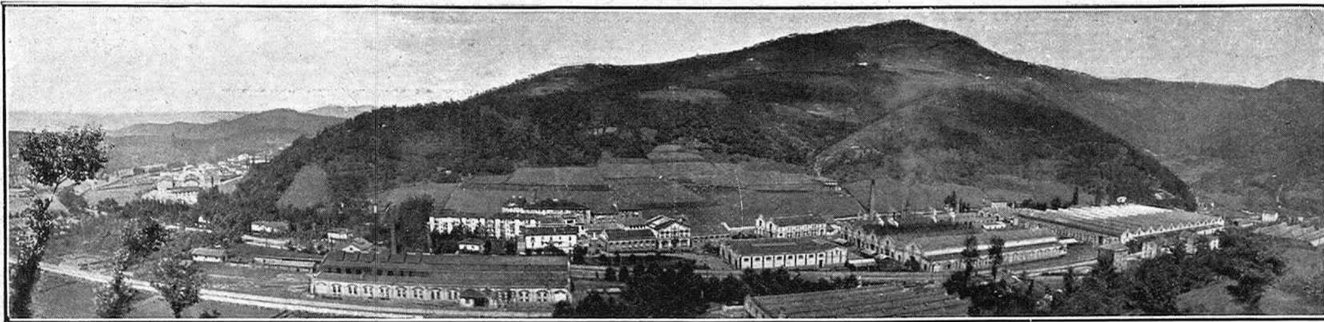
Vista panorámica de la fábrica de la Sociedad Española de Construcciones Metálicas, en Beasain
