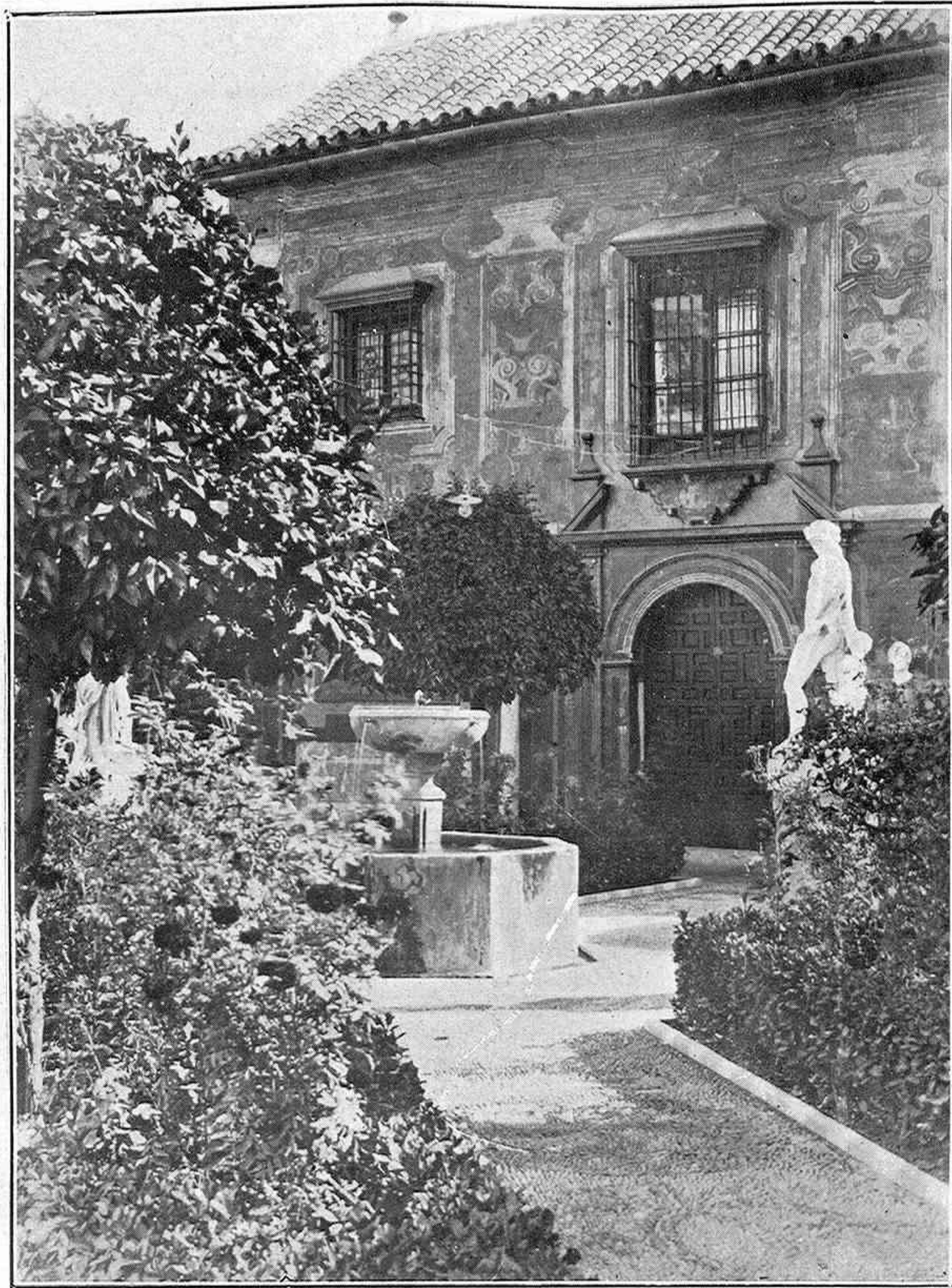
Un detalle del patio del Museo. En el frente del edificio se ven las pinturas al fresco descubiertas por D. Enrique Romero de Torres
