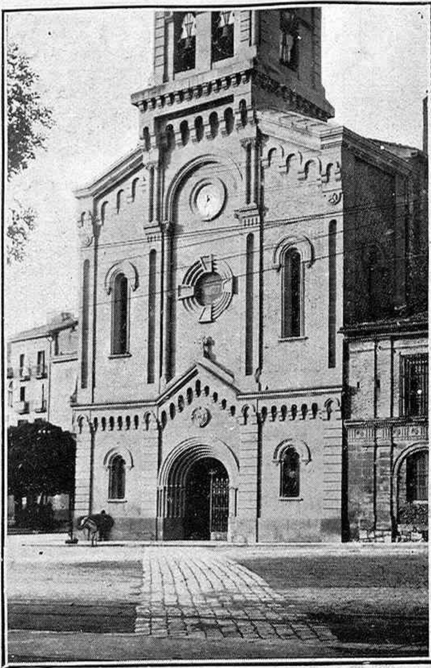
Fachada de la iglesia de San Lorenzo, donde se venera la imagen de San Fermín
