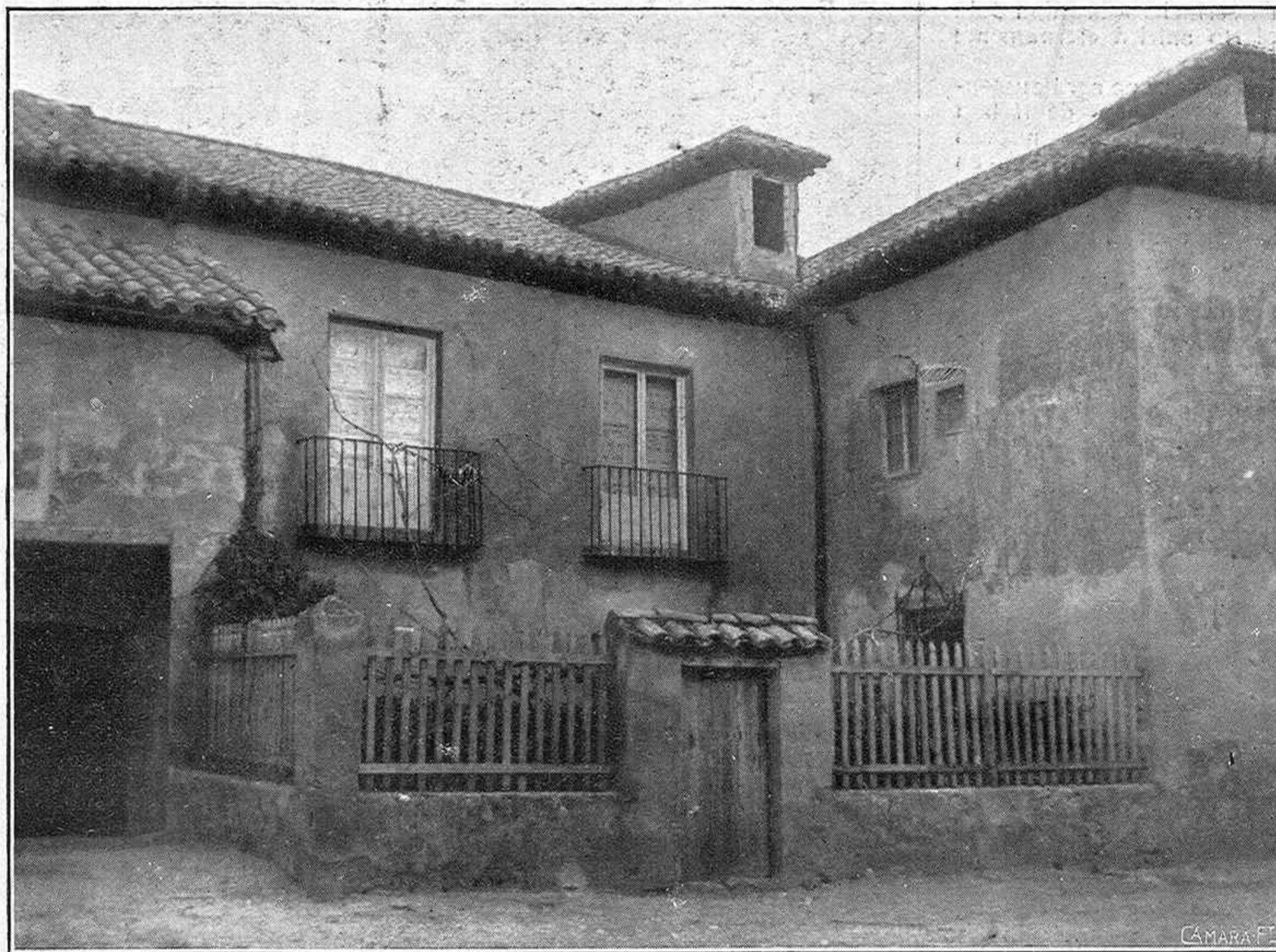
Fachada posterior de la casa de la esposa de Cervantes, en Esquivias
