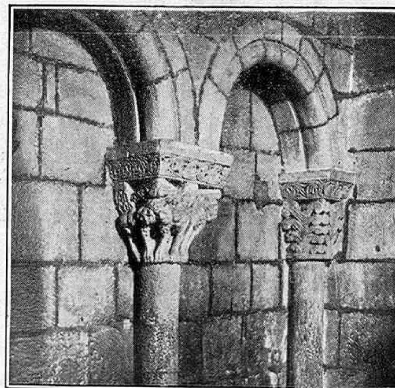
Detalle de las columnas del ábside
