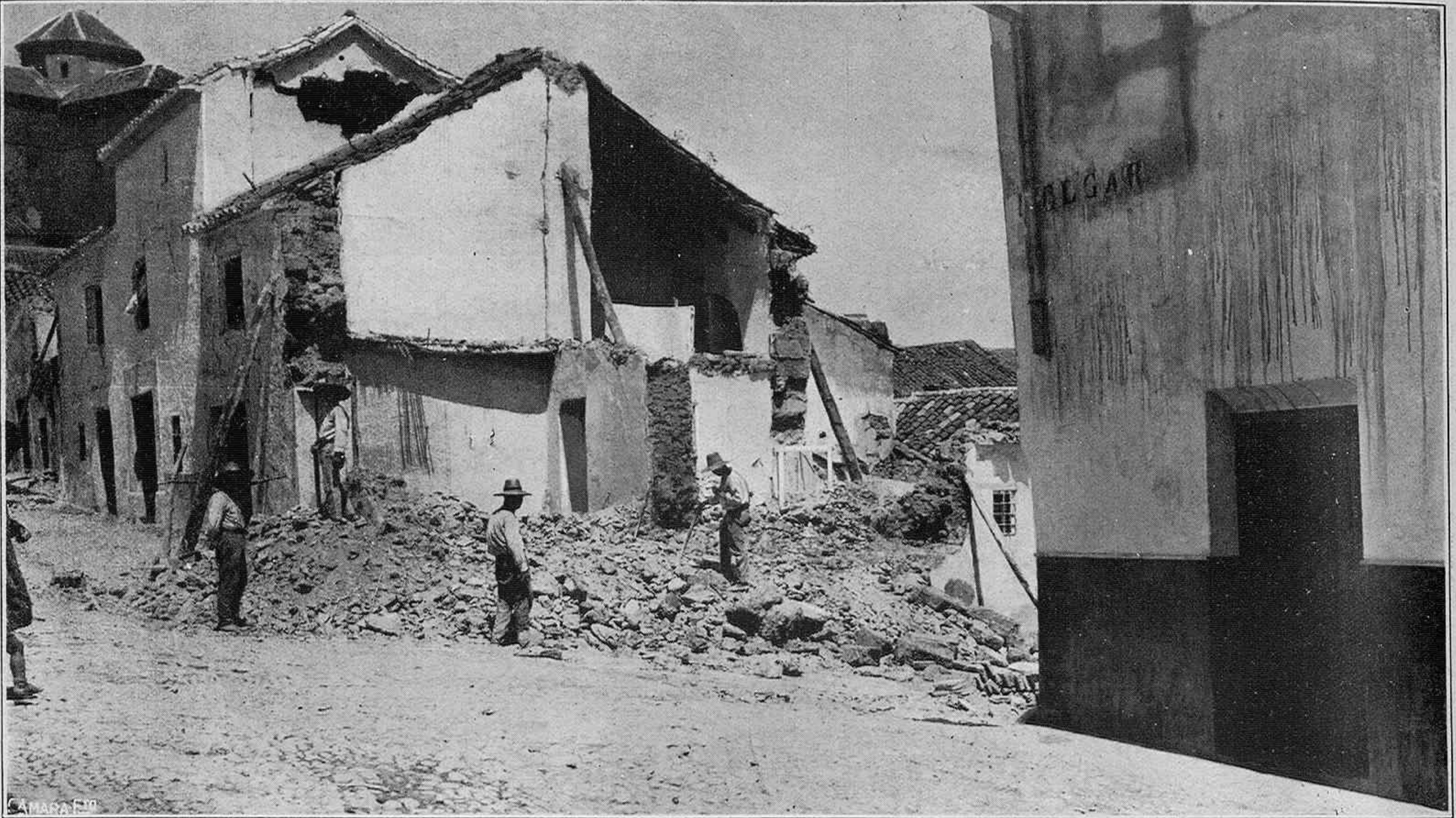
Montilla.—Grupo de casas hundidas y otras peligrosamente agrietadas, en una de las principales calles de la ciudad, después del terremoto que produjo tantos destrozos
