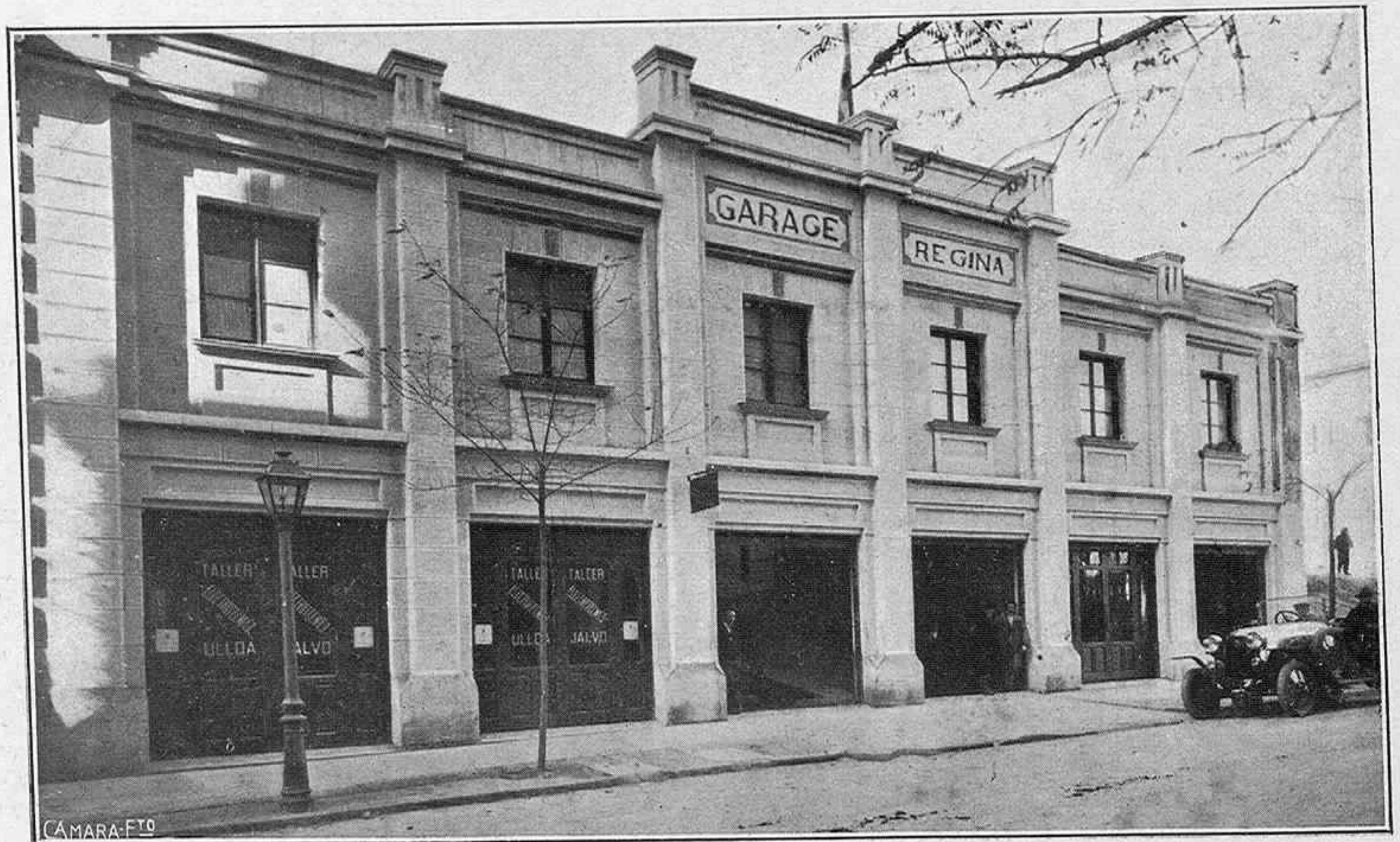
Fachada del edificio del GARAGE REGINA
