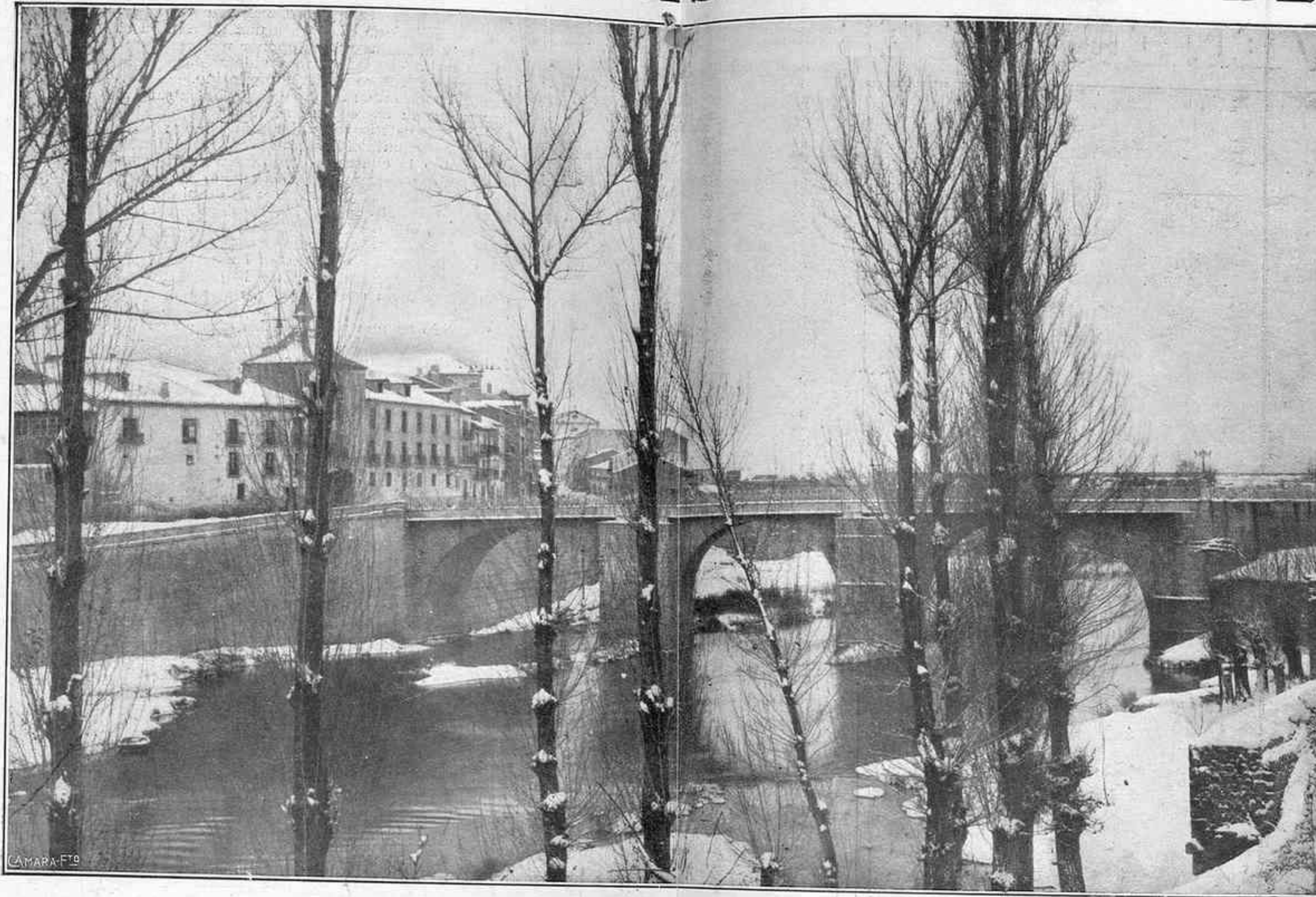
Aranda de Duero.—Puente sobre el Duero
