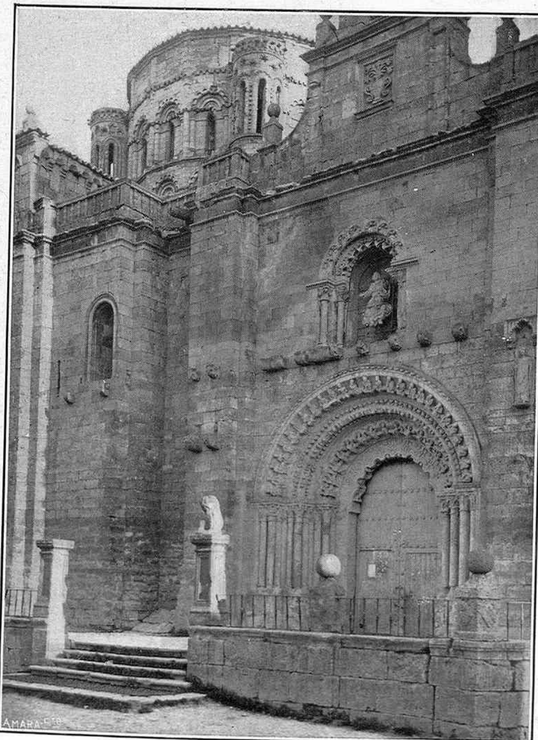
Fachada Norte de la iglesia mayor de Toro
