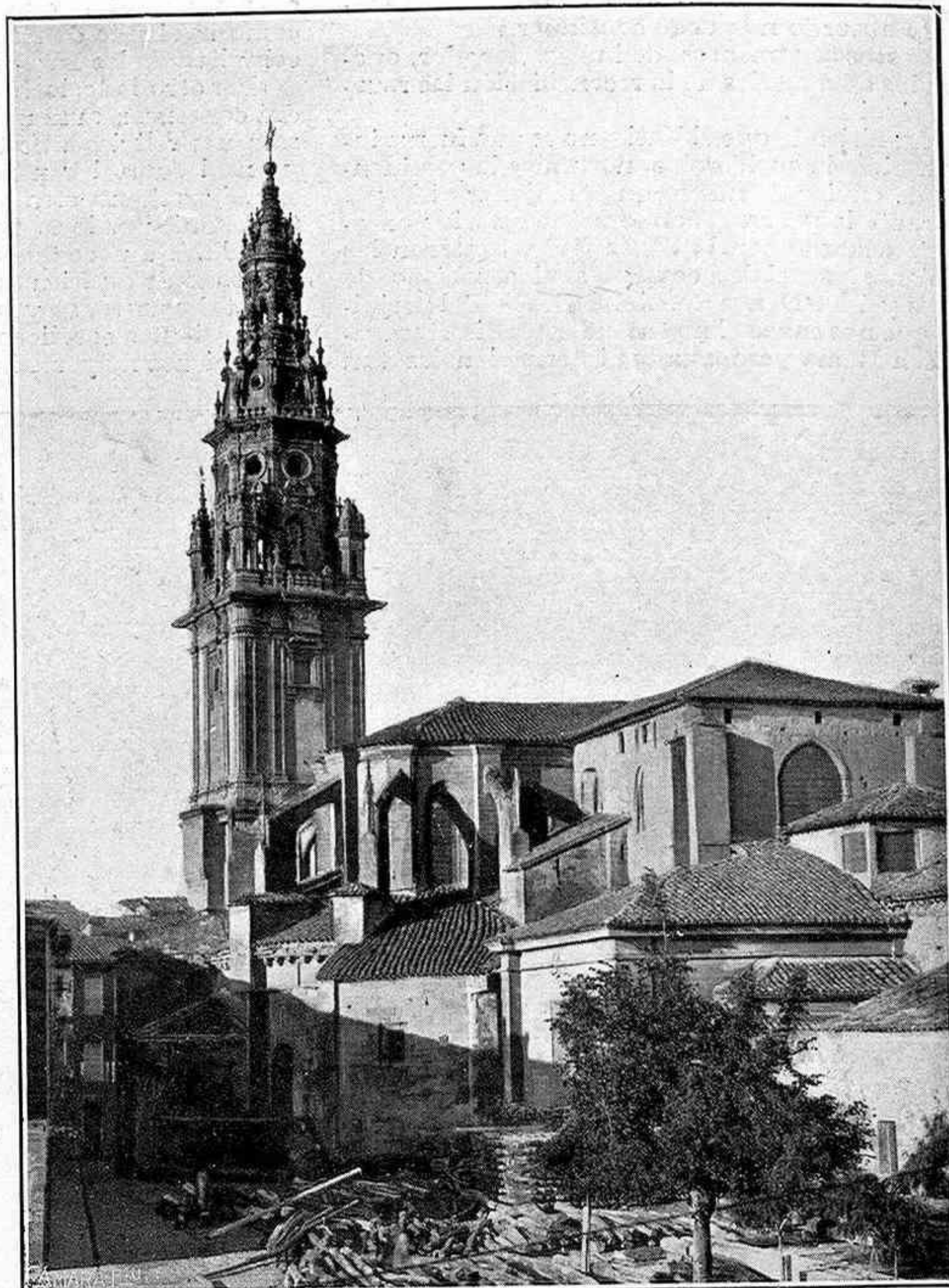
Torre borrominesca de la Catedral
