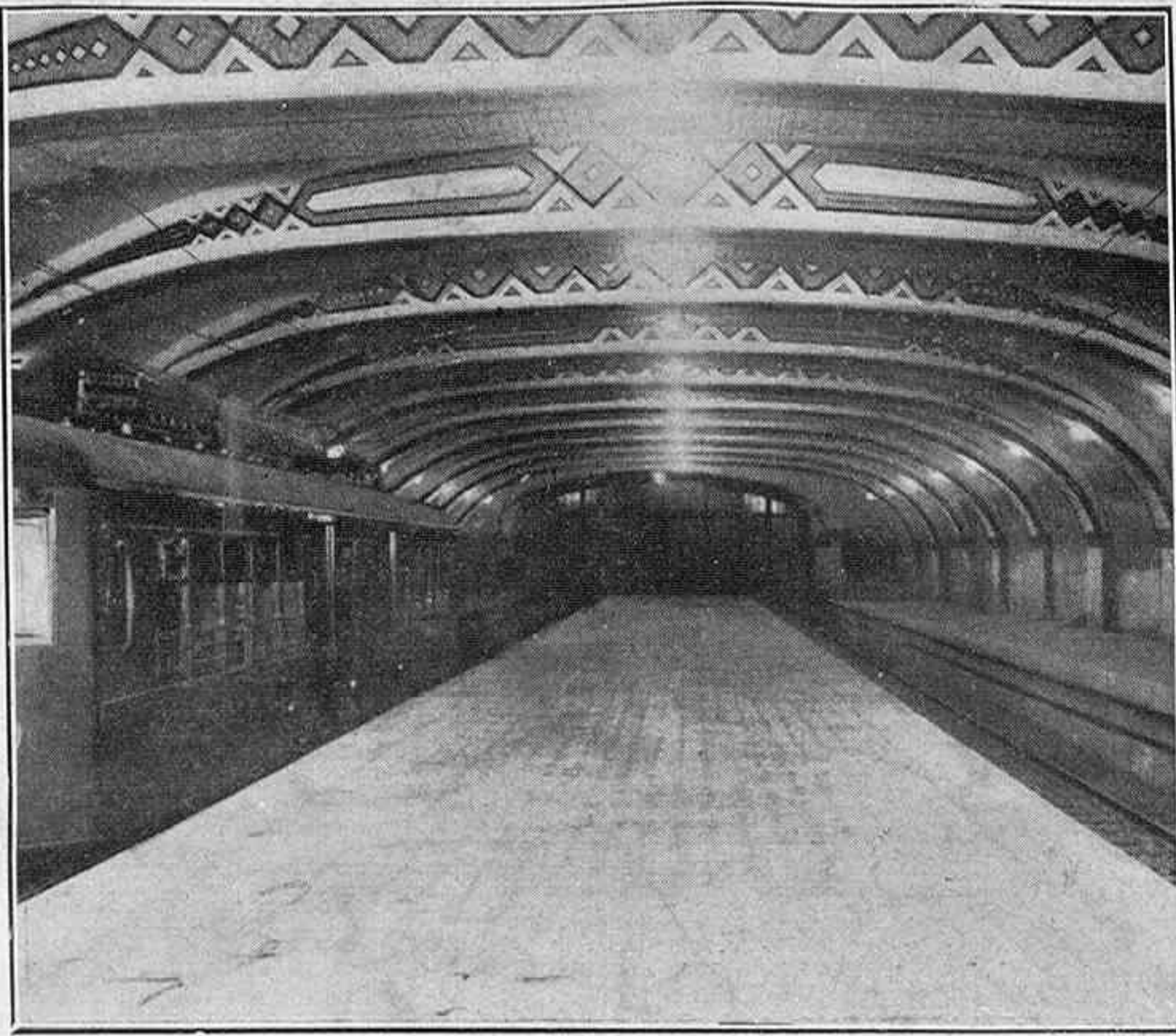
Estación subterránea del ferrocarril de Sarriá, en la Plaza de Cataluña
