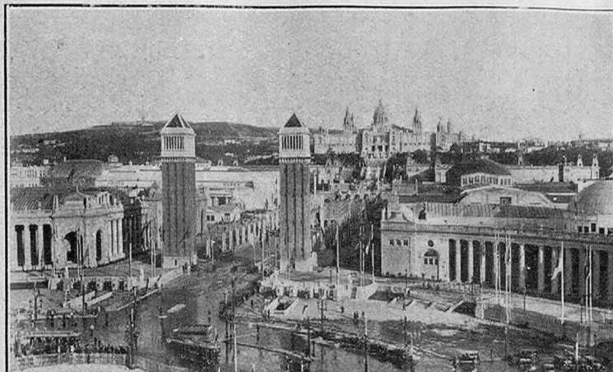
Aspecto de la Plaza de España por la parte de entrada a la Exposición
